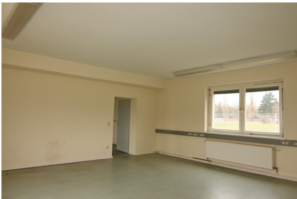
2. Erweiterung 1984. Raum 1. Blick auf Fenster F 1.5, links Tür TI 1.4.
