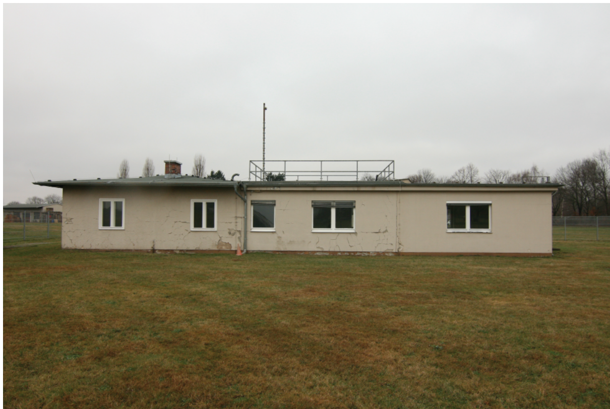
Südostseite, links Kernbau von 1940.
