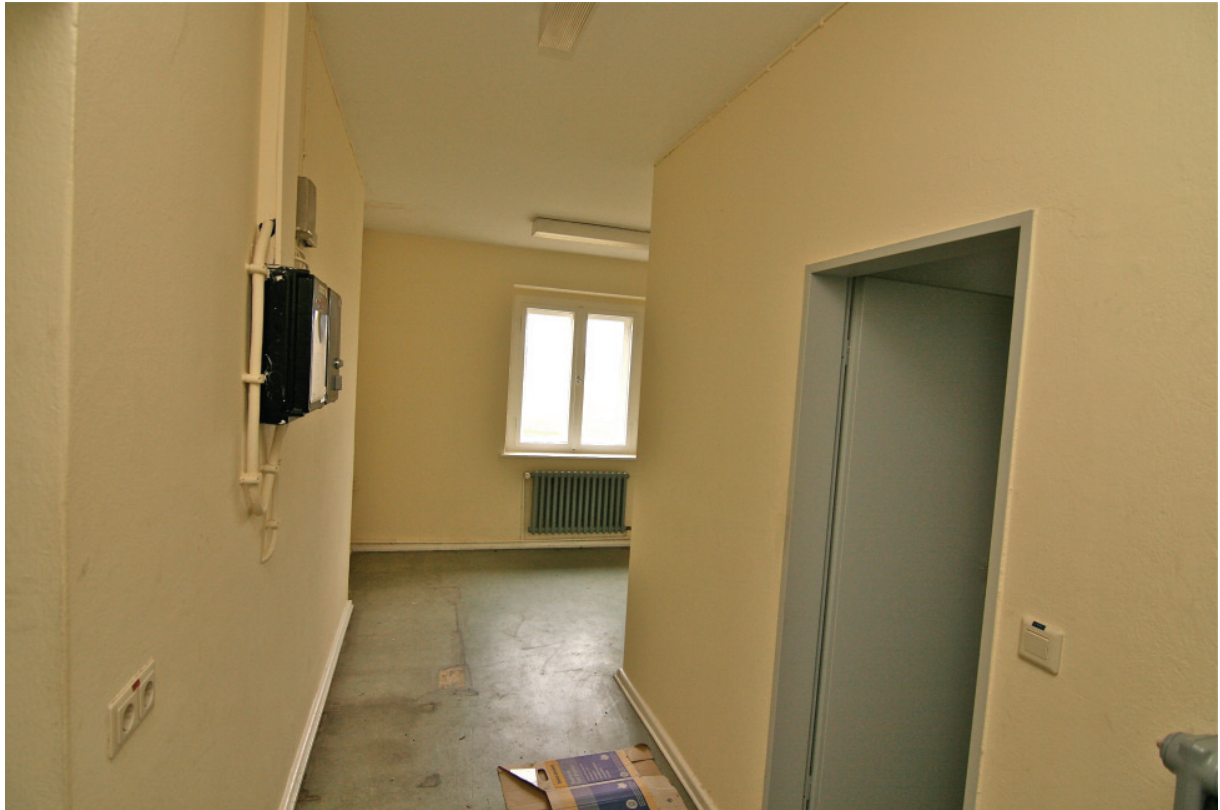
Kernbau von 1940. Raum 5, Blick vom Eingang TA 1.
