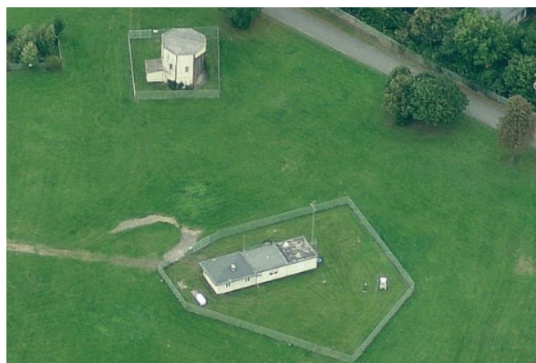
Gebäude 104 und Ballonhalle 103 (oben), 2012 (Bing Maps).
