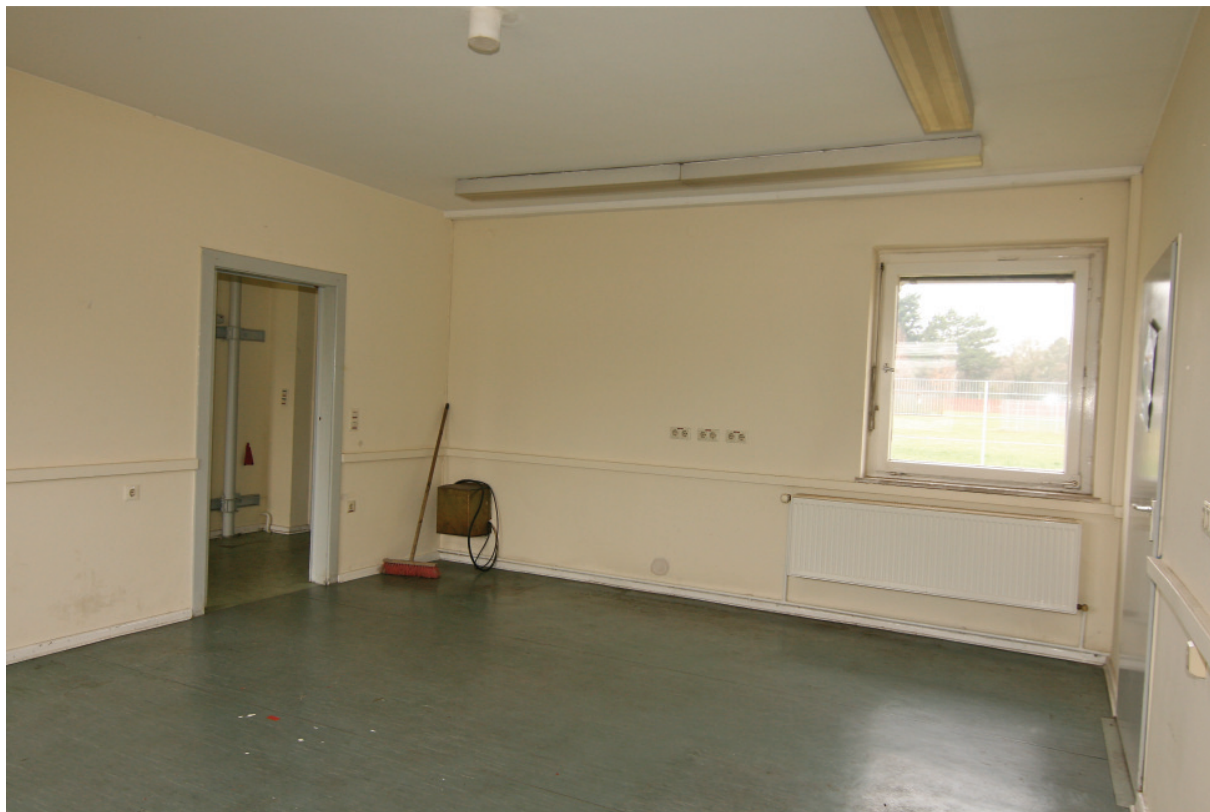
1. Erweiterung um 1972. Raum 2, Blick auf Fenster F 1.4, links Tür TI 1.2, rechts TI 1.1.
