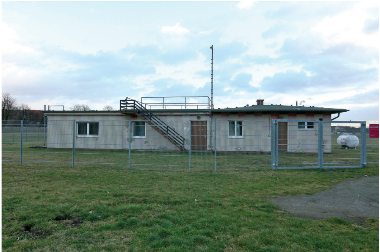
Blick von Nordwesten, 2012. Rechts Kernbau von 1940.
