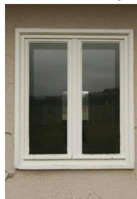
Raum 4, Kastendoppelfenster F 1.8 aussen.
