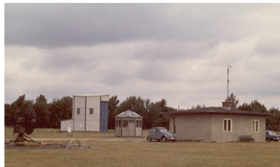
Ehemalige Radiosondenstation Tempelhof mit Ballonhalle und Gebäude 104. Zustand 1968 noch ohne Anbauten. (Institut Meteorologie FU).
