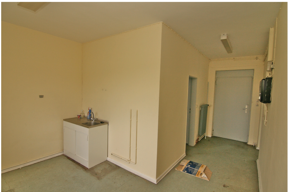
Kernbau von 1940. Raum 5, Blick nach der Eingangstür TA 1.
