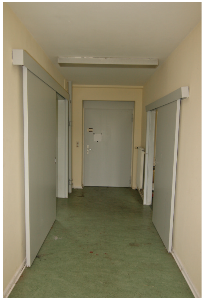
1. Erweiterung um 1972, Raum 3, Blick auf Eingang TA 2. Rechts und links Schiebetüren TI 1.2 und TI 1.3.
