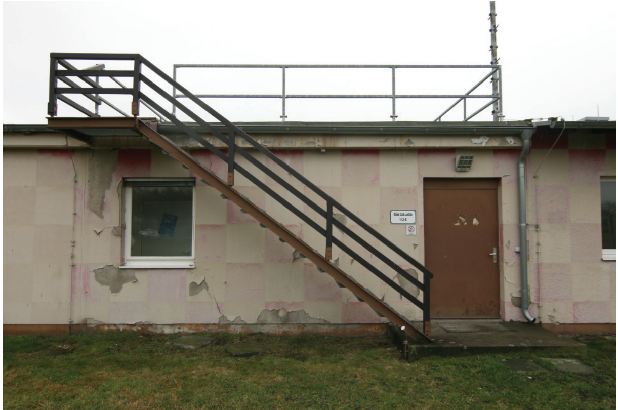
1. Erweiterung um 1972. Eingang TA 2, Stahltreppe zur Dachterrasse.
