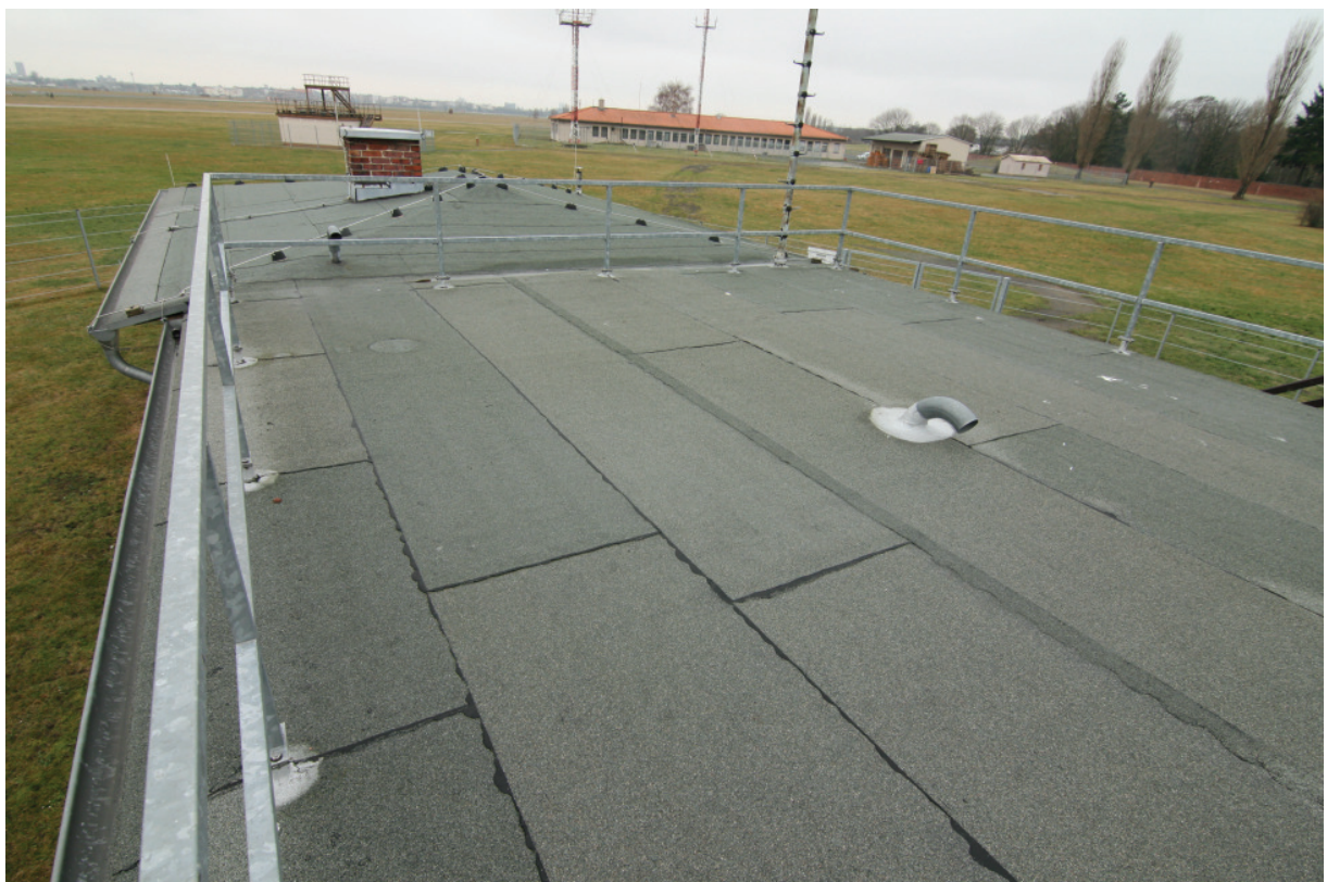
1. Erweiterung um 1972, Dachterrasse. Im Hintergrund Dach Kernbau.
