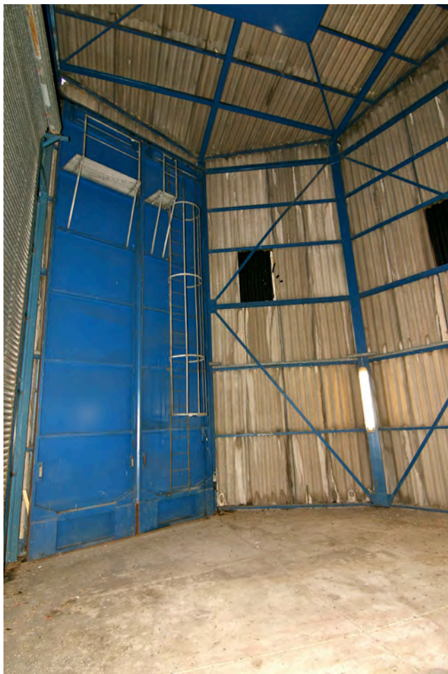
Ballonhaus, links zwei der früheren Stahlschiebetore.
