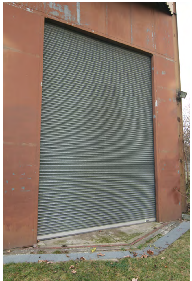
Rolltor, am Fußpunkt die Betonfundamente der Führung der ehemaligen Schiebetore noch vorhanden.
