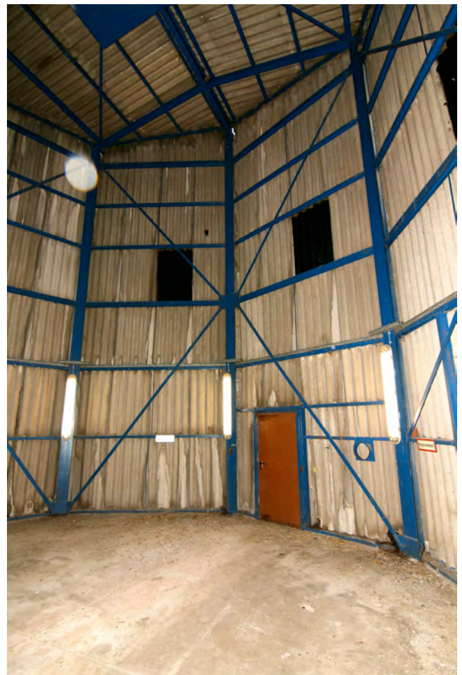
Ballonhaus, Eingang TA 1.
