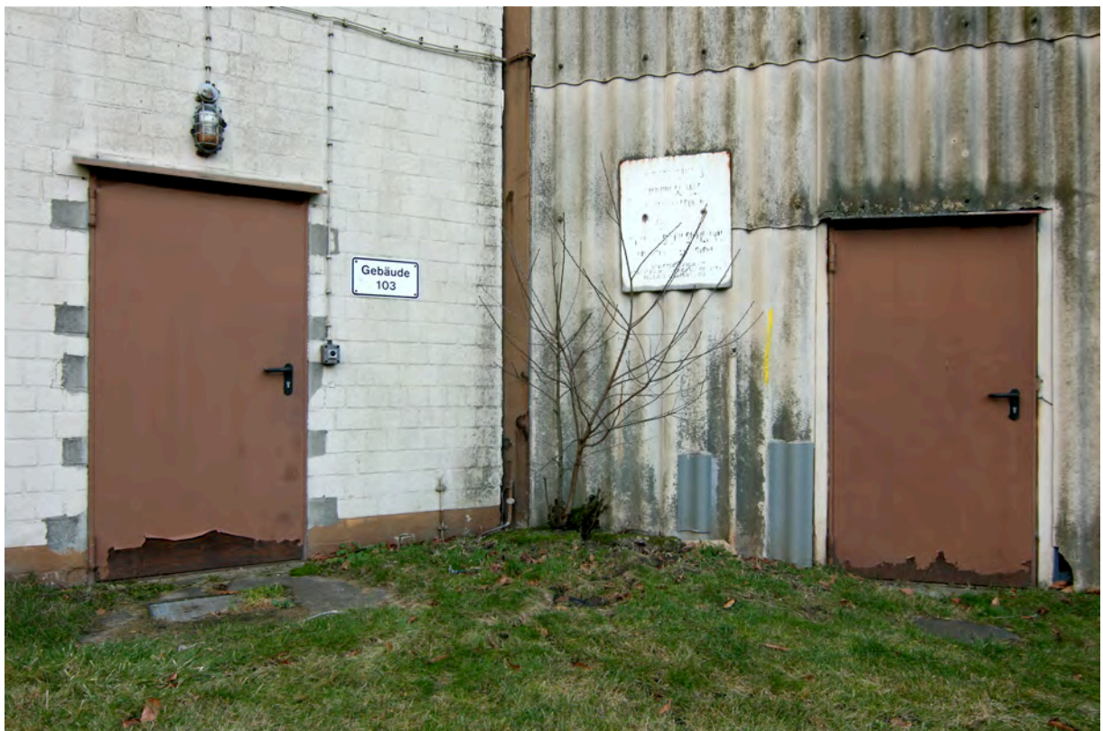
Eingänge, links TA 2 zum Target-Raum, rechts TA 1 zur Ballonhalle.
