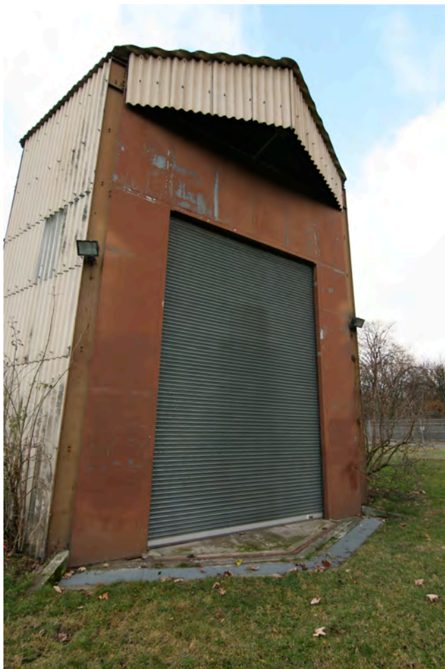
Ostseite mit neuer Stahlwand und Rolltor.
