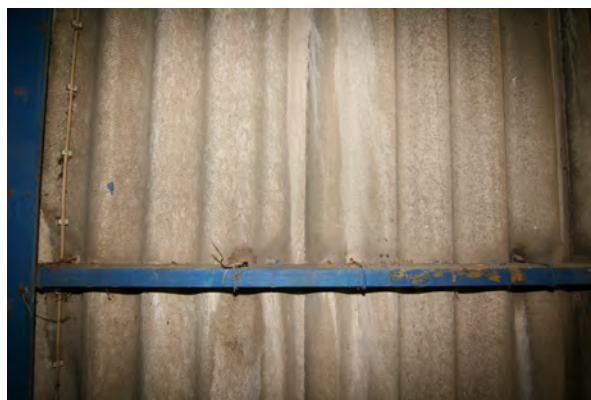
Wellasbestzementplatten-Verkleidung innen.
