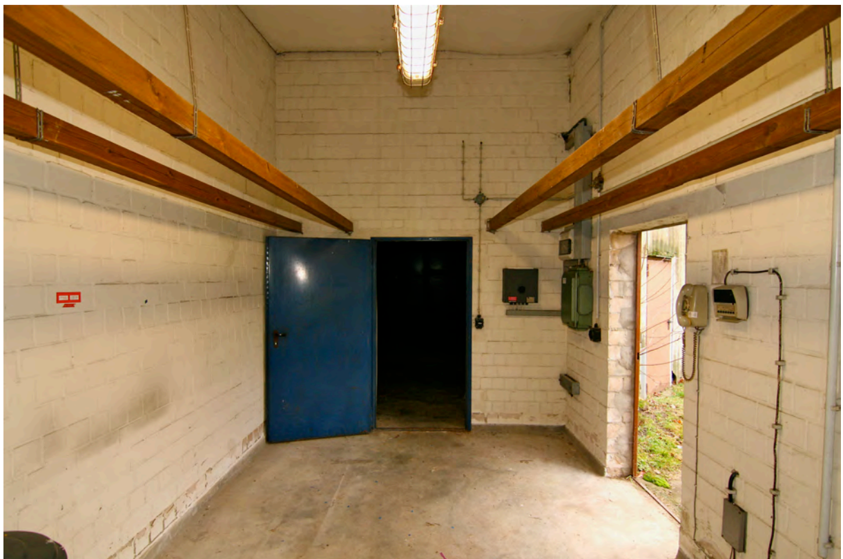
Anbau Target-Raum, Mitte Tür TI 1.1 der Ballonhalle, rechts Eingangstür TA 2.
