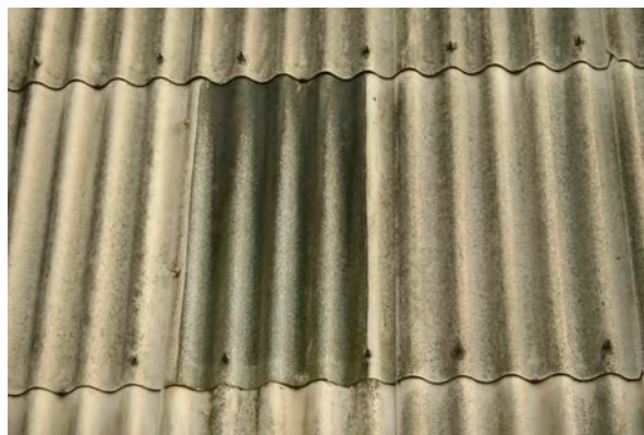
Wellasbestzementplatten-Verkleidung aussen mit "Fenster".
