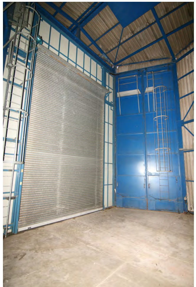
Ballonhaus, links neues Rolltor, rechts zwei der früheren Stahlschiebetore.
