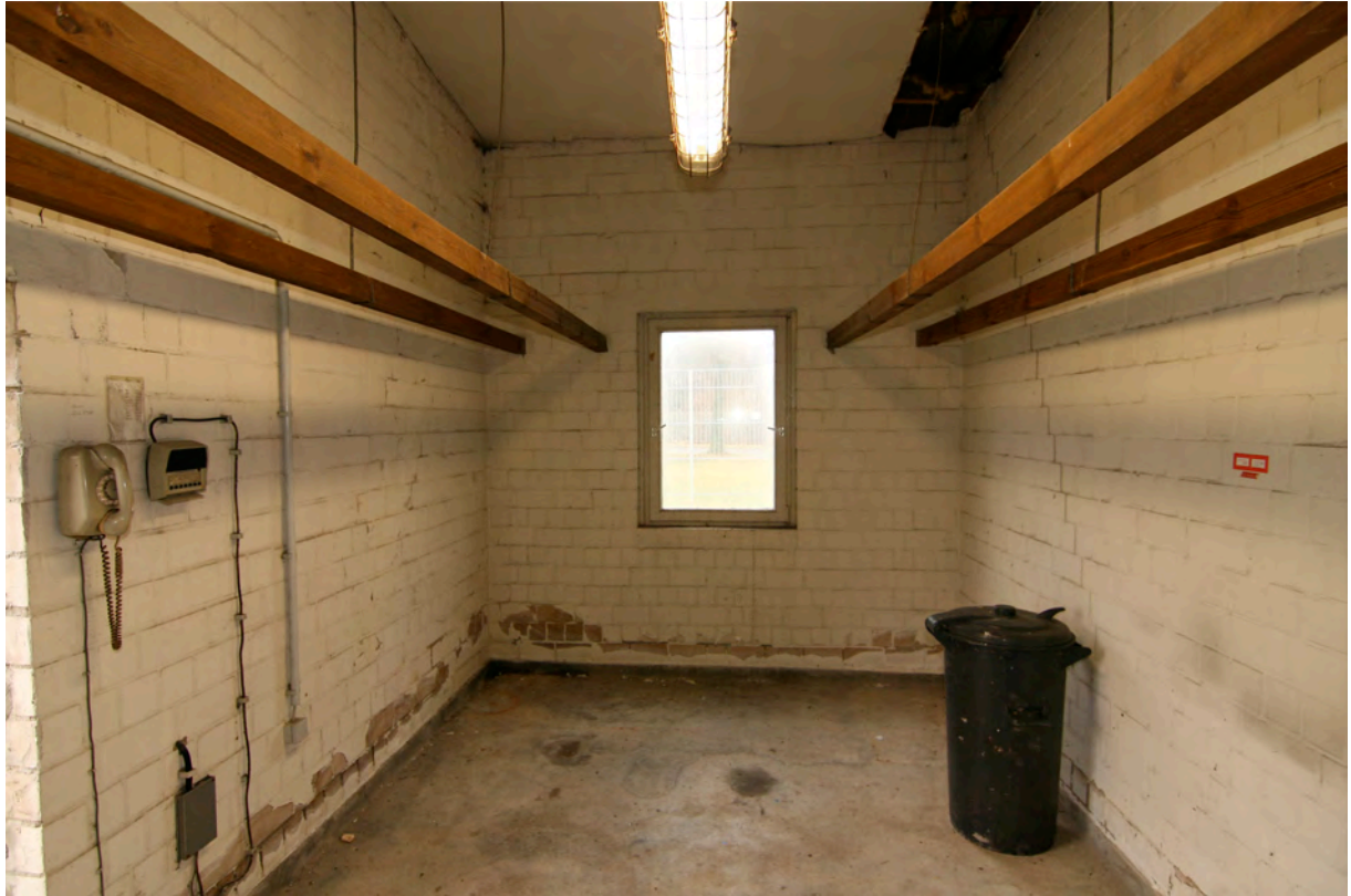
Anbau Target-Raum von 1974, Fenster F 1.1.
