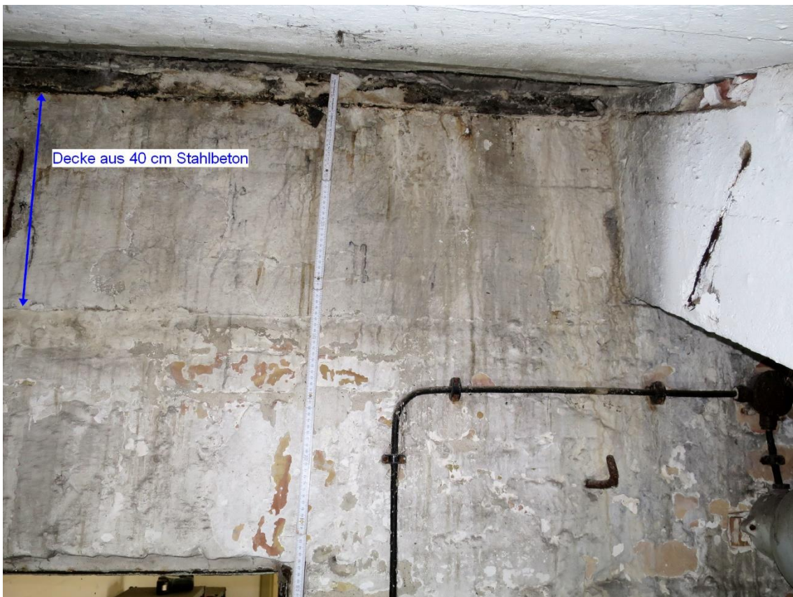
Gemauerte Wand zwischen Raum 1 und 2 auf der die Deckenplatte (Podest) aus Stahlbeton aufliegt.
