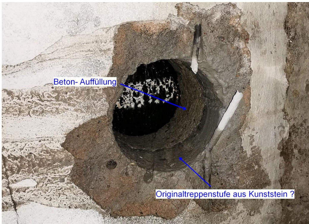
Öffnung 1 mit Kernbohrung 4/ Ansicht von unten
