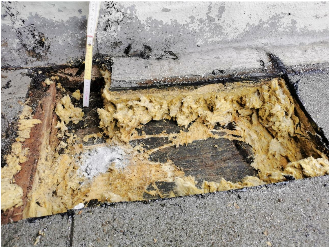
Öffnung 2 mit Bohrkern 6 Bitumenbahn auf Mineralwolle
