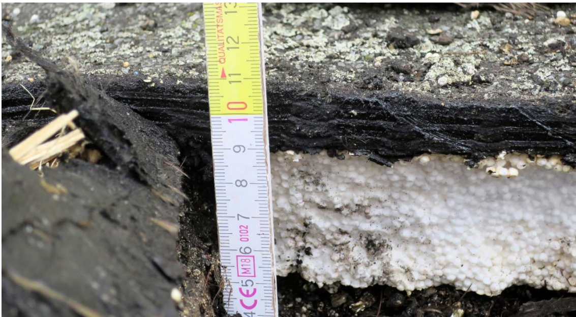
Öffnung 1/ Bitumenbahnen auf EPS- Platten
