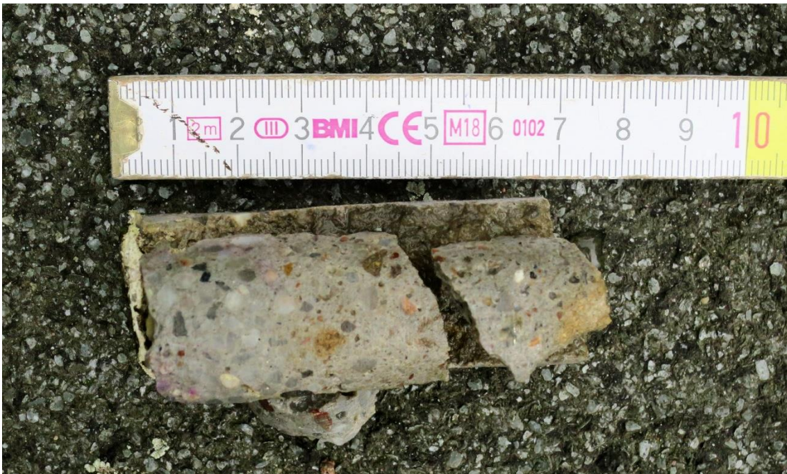
M3/ Der Riss reicht durch den gesamten Kern.
