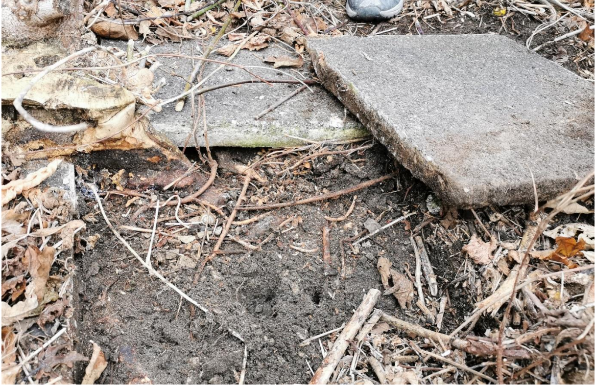
Die Betonplatten (40x 40 x 4 cm 3 ) liegen unmittelbar auf dem Erdreich auf.
