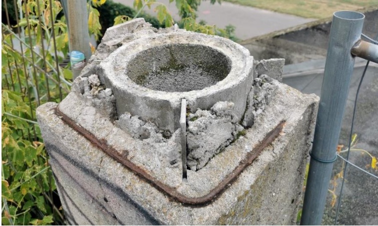
Oberseite vom Pylon ohne Lichtkasten 2020
