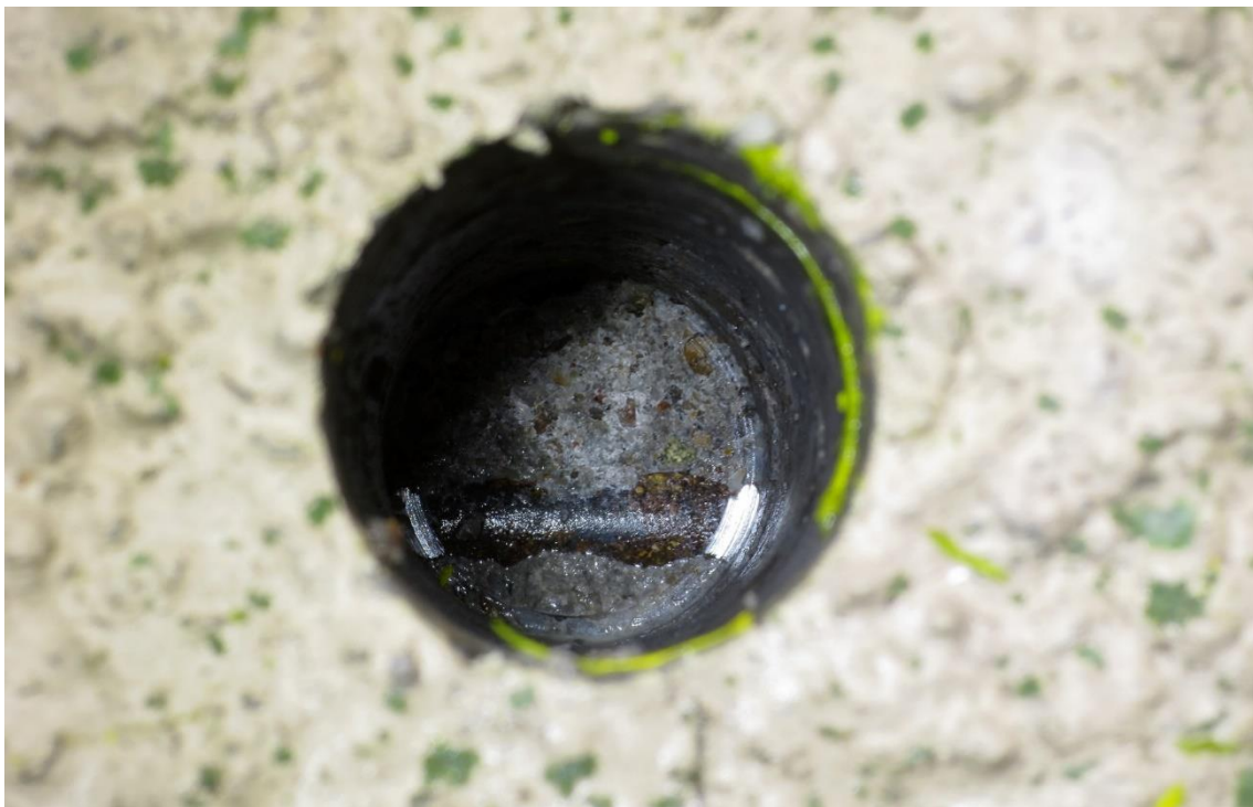
M2/ Bewehrung in 100 mm Tiefe ohne Korrosion
