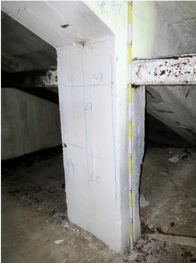
Raum 1/ Stütze mit Lage der Bewehrung und Überdeckung (Angaben in mm)
