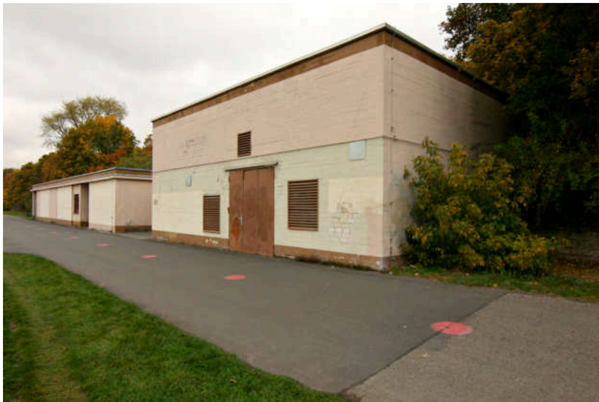
Blick von Süden, 2016. Im Vordergrund Generatorenstation.
