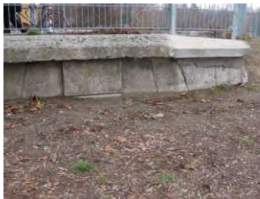
Futtermauer von 1906. Pfeiler mit Putzfuge, 2019
