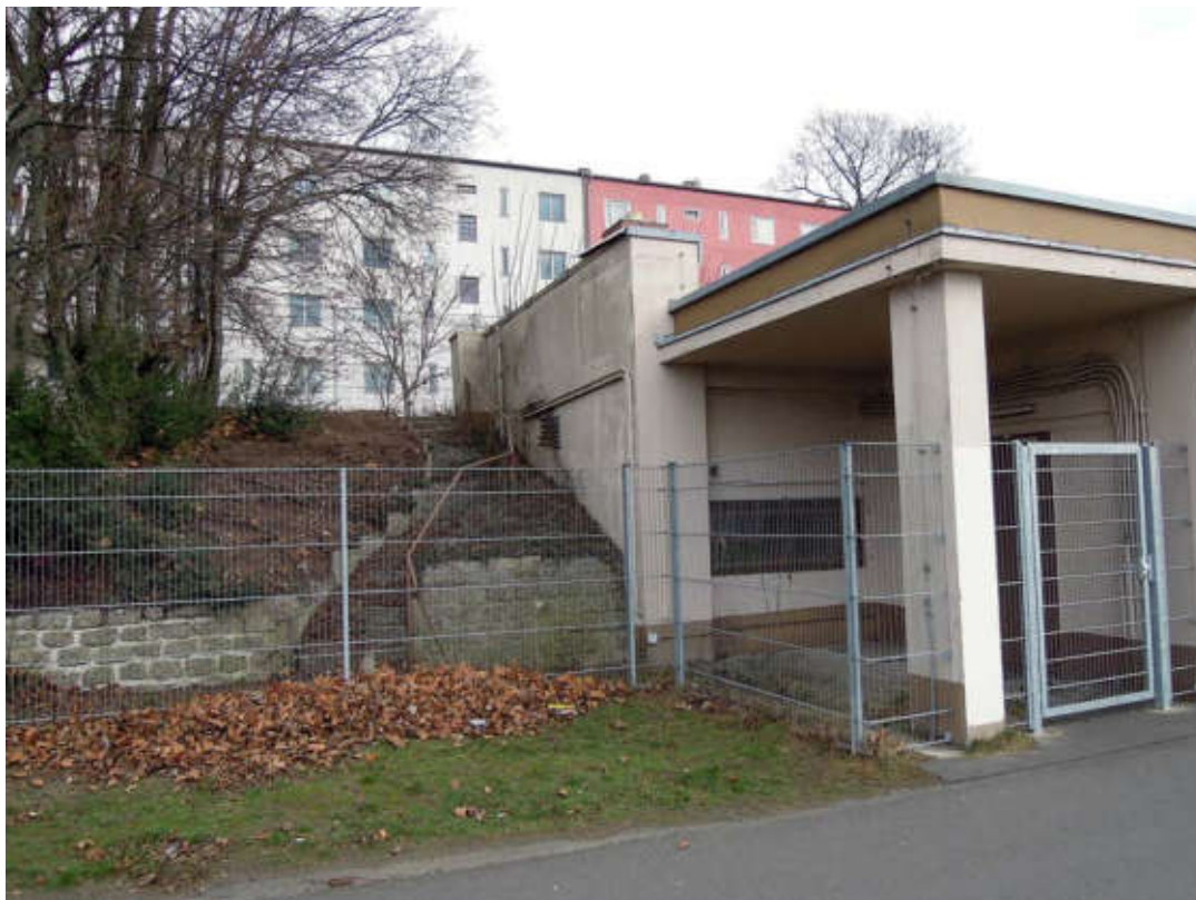
Böschungstreppe auf der Nordseite des Gebäudes 105, Flugfeldseite.
