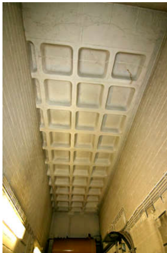
Raum 1, Schalraum. Stahlbeton-Kassettendecke, 2016.
