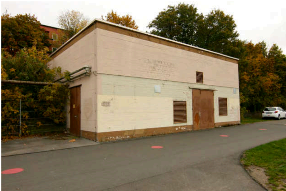
Nordseite. Eingang Stahltür TA 1.
