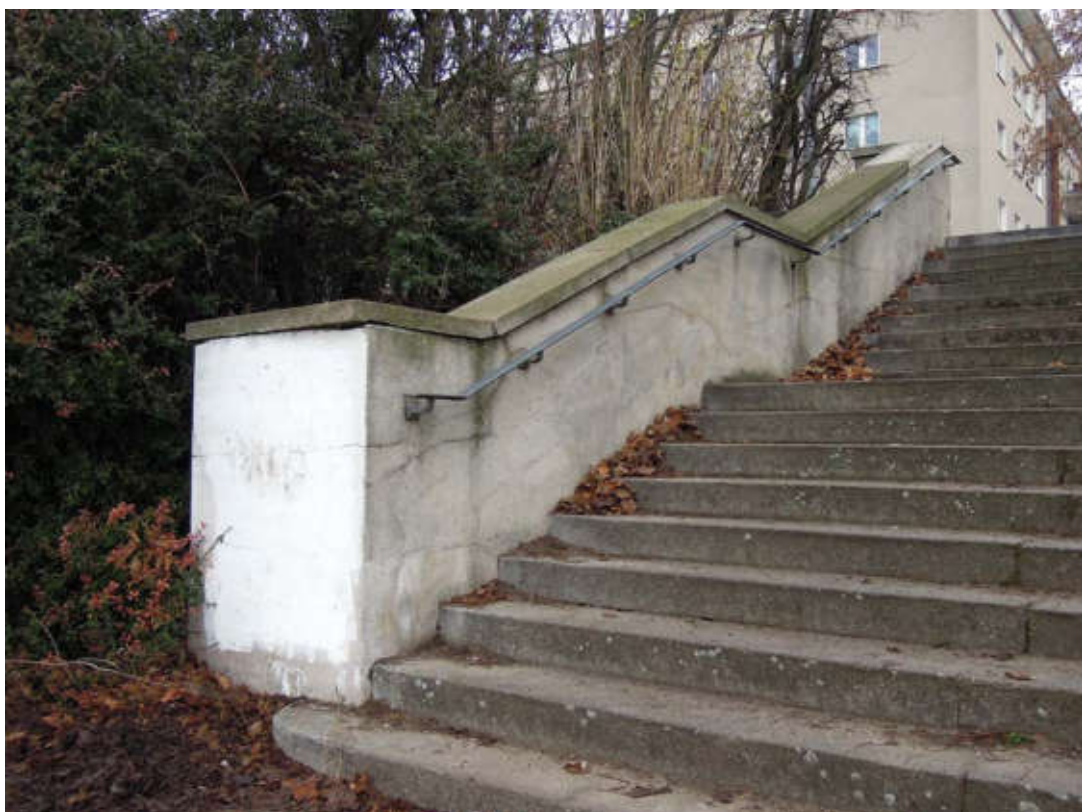
Brüstung Nordseite. Blick vom Flugfeld.
