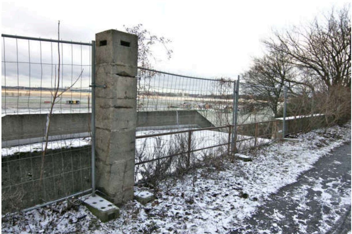
Rest der ursprünglich zwei Betonpylone, ehemals mit Lichtkästen bekrönt, 2013.
