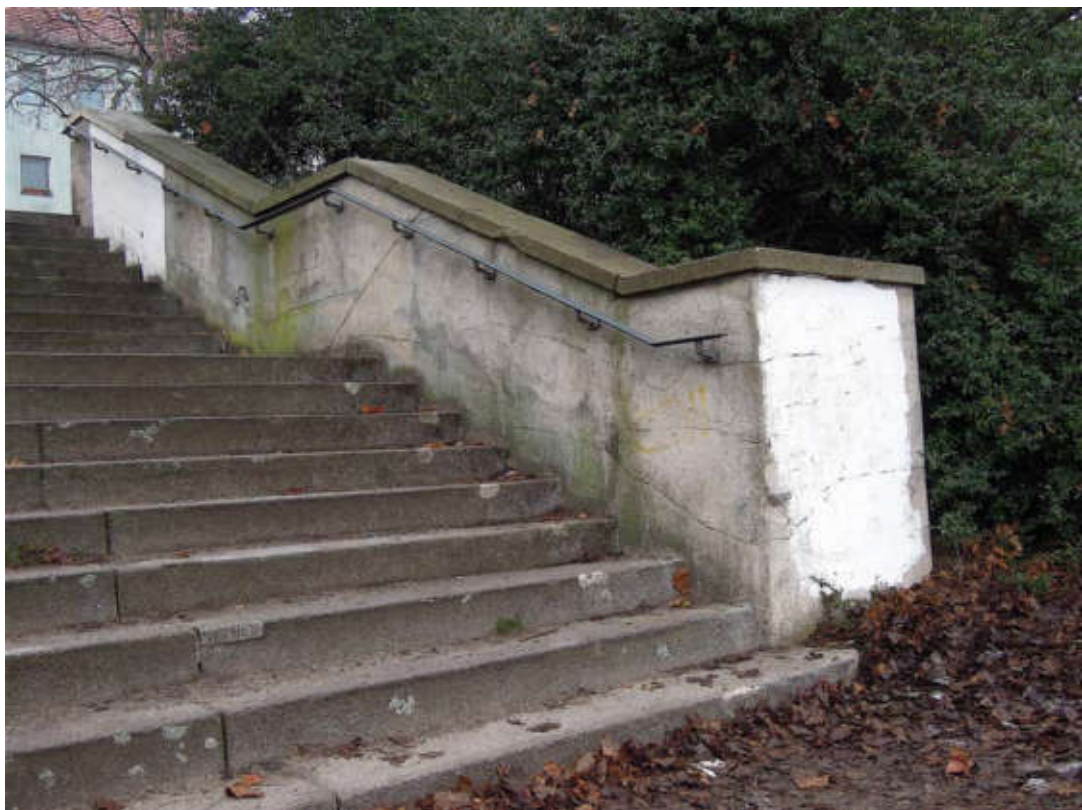
Brüstung Nordseite, Blick vom Flugfeld.
