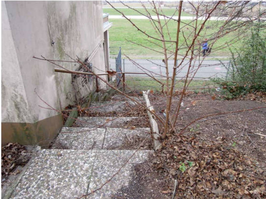
Oberhalb der Böschung, Ebene Oderstraße. Antritt.
