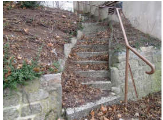
Blick von der Flugfeldseite. Rohrgeländer.
