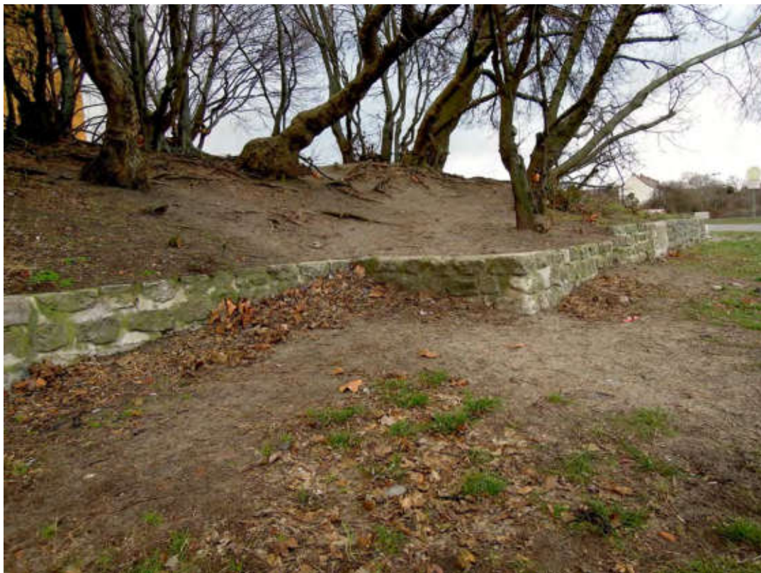
Böschungsmauer südlicher Abschnitt, Gebäude 113 bis Landebahn Süd (Crashgate).
