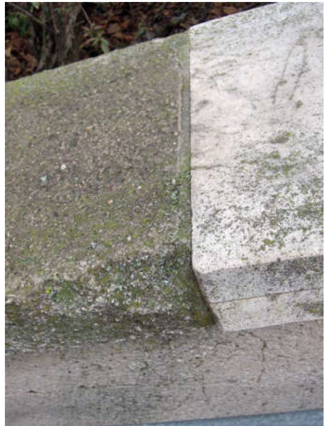
Bauzeitliche und erneuerte Kunststeinabdeckung der Brüstung.
