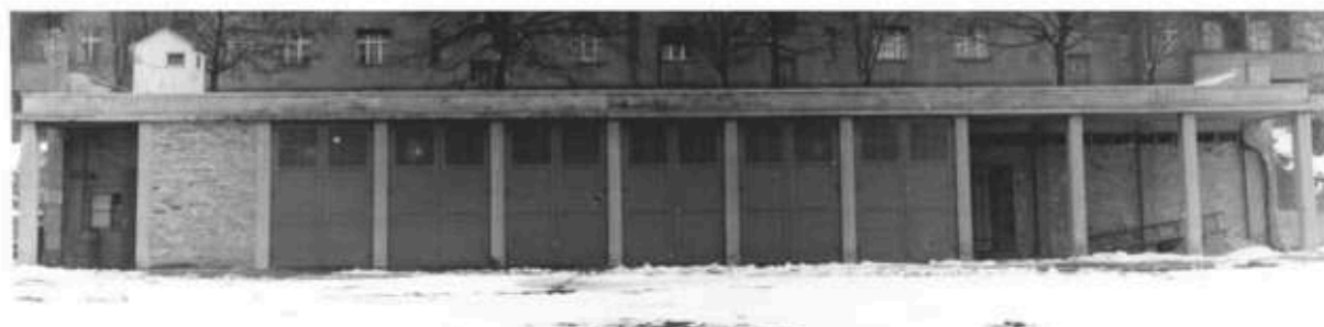
Zustand um 1949 nach dem Umbau für die US Air Force zu einer Generator-Station (Archiv Tempelhof Projekt).
