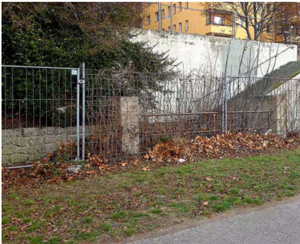
Böschungsmauer südlicher Abschnitt bei Gebäude 113 (ehem. Treppe Leinestraße).
