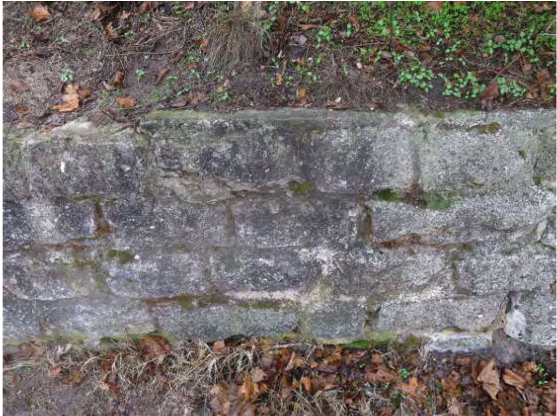
Böschungsmauerwerk aus Betonkunststeinen in Bruchsteinoptik.
