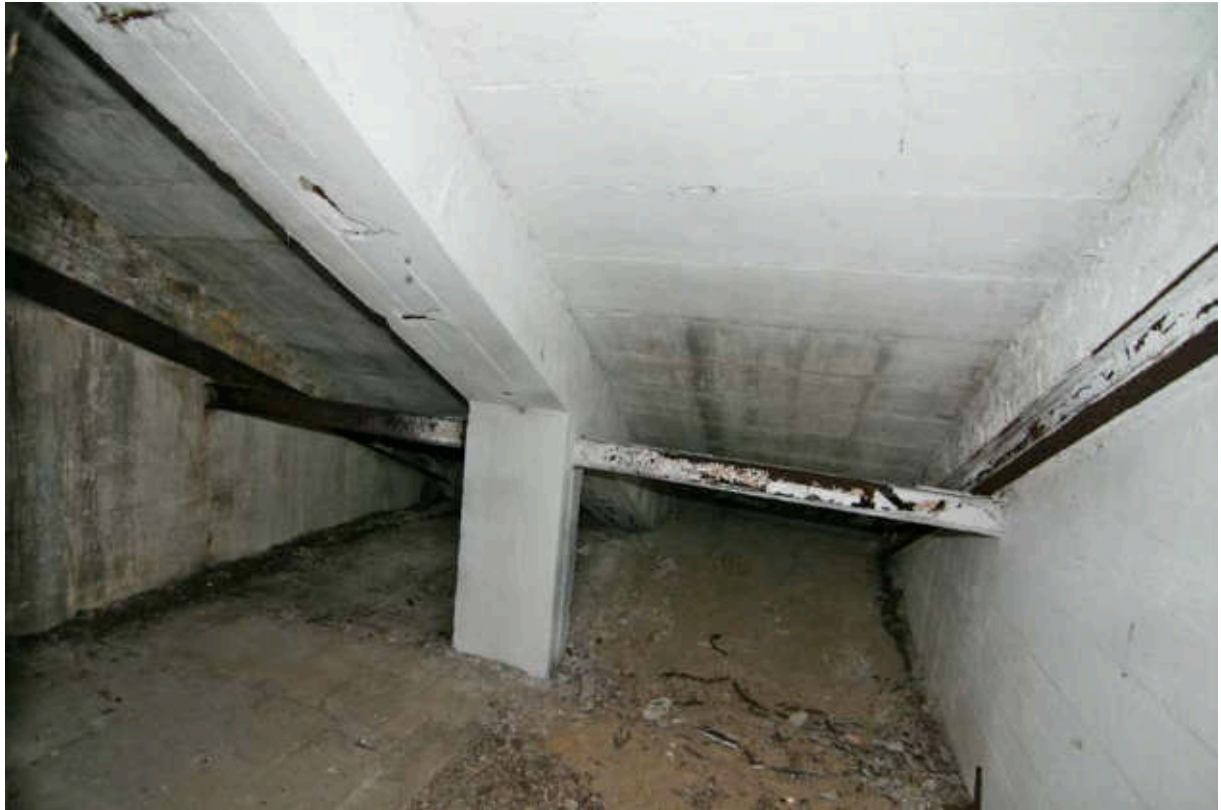
Raum 1, Raum unterhalb des südlichen Treppenlaufes, Eisenbetonkonstruktion.
