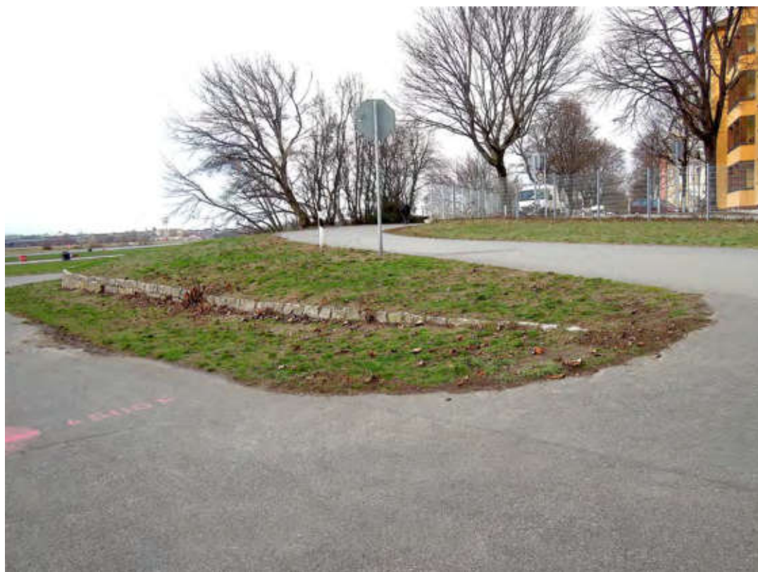
Böschungsmauer südlicher Abschnitt, Gebäude 113 bis Landebahn Süd. Endpunkt bei Crashgate.
