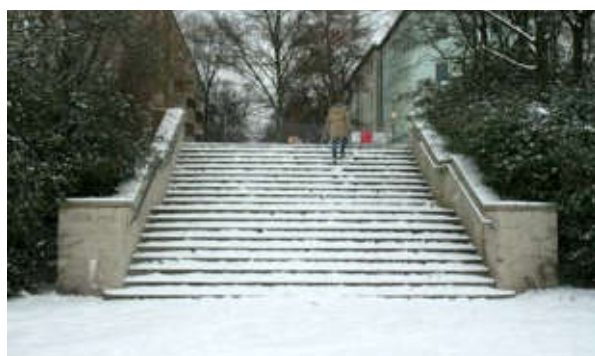
Zugangstreppe auf Höhe der Kienitzer Straße, 2013.
