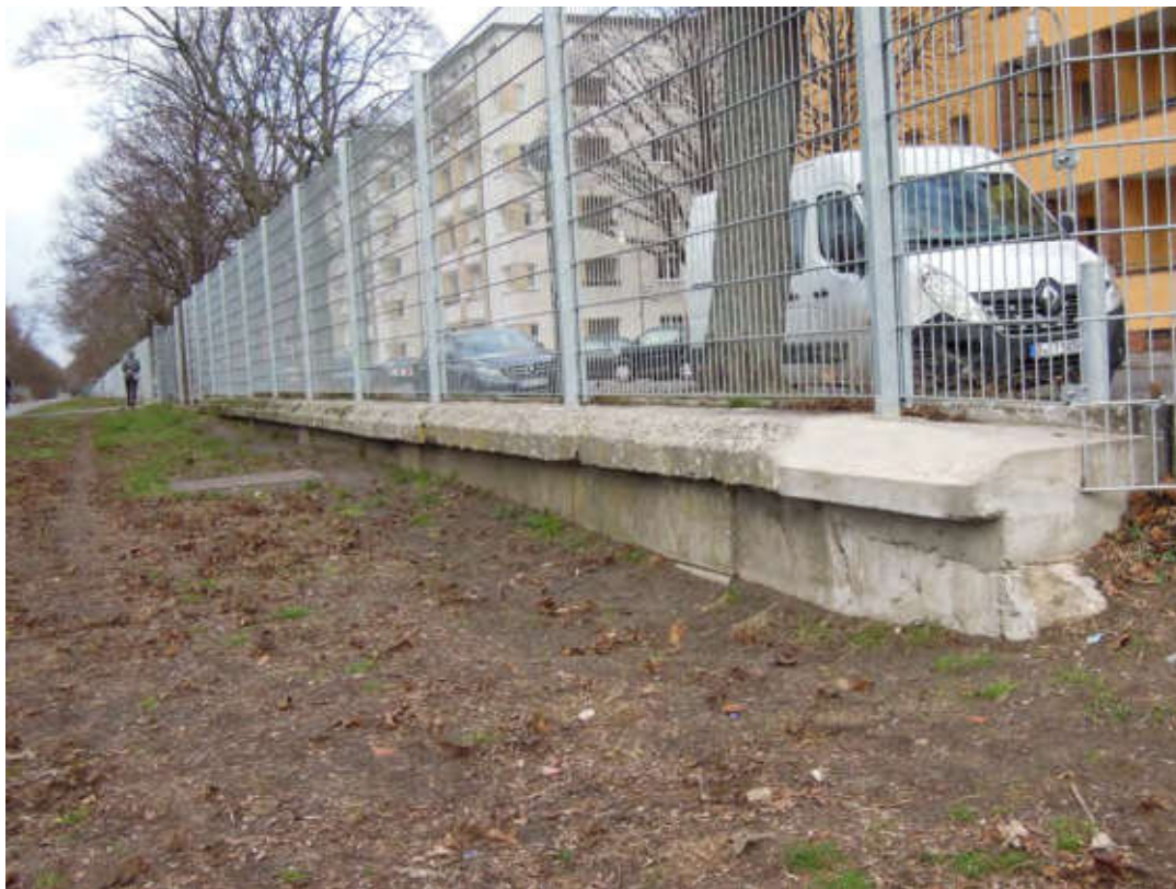
Promenade, südliches Ende. Randbegrenzung, Eingeschüttete Futtermauer von 1906 mit Ausbesserung.
