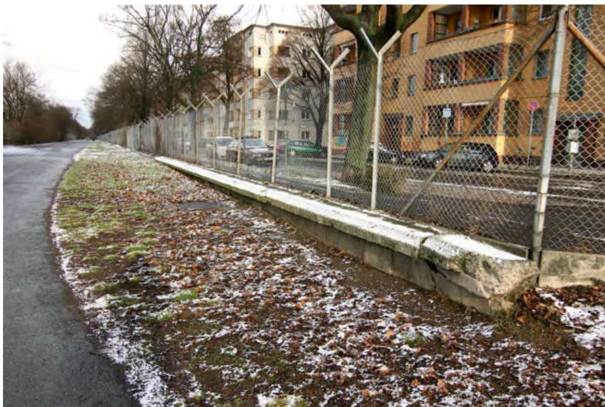
Promenade, südliches Ende. Randbegrenzung, Eingeschüttete Futtermauer von 1906. Vor der Ausbesserung 2013.
