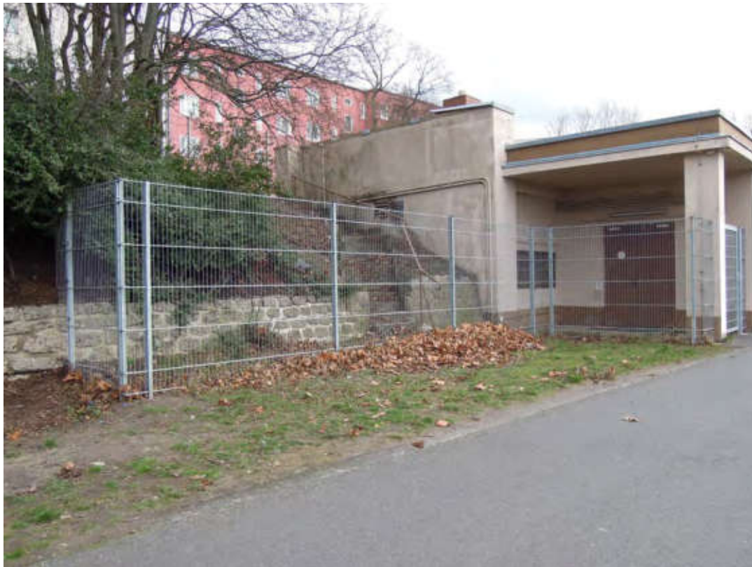
Böschungsmauer, mittlerer Abschnitt Treppe Kienitzer Straße bis Gebäude 105 (rechst).
