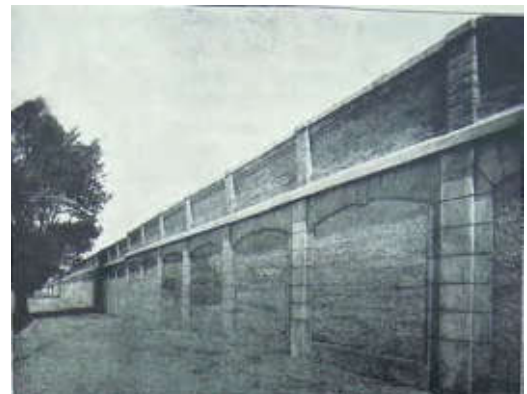
Futtermauer von 1906, um 1925 eingeschüttet.
