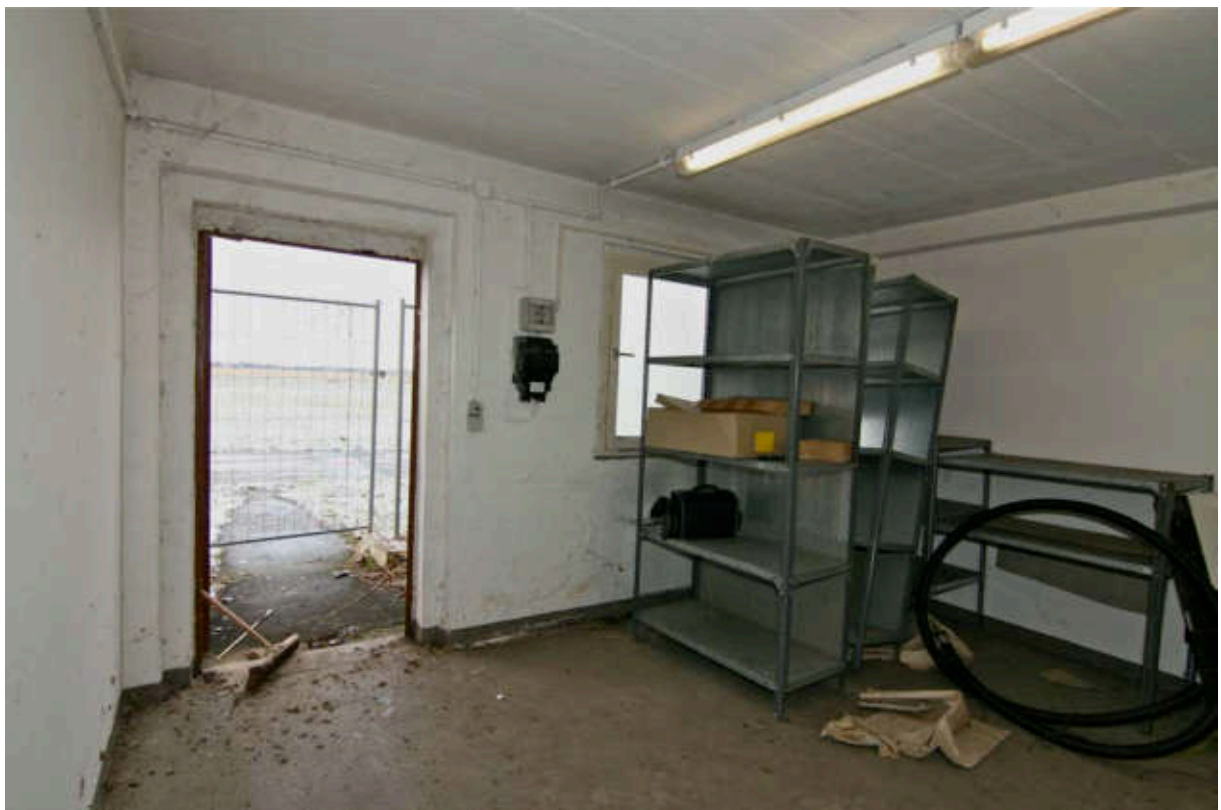
Raum 2, Eingang TA 2 und Fenster F1.1.
