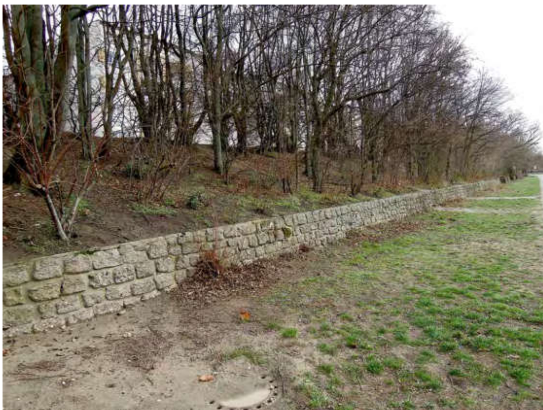
Böschungsmauer südlicher Abschnitt Gebäude 128 bis Gebäude 113, Banknischen im Hintergrund.
