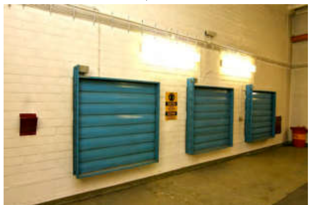
Trennwand zu Raum 3. Zuluftöffnungen F7-F9.
