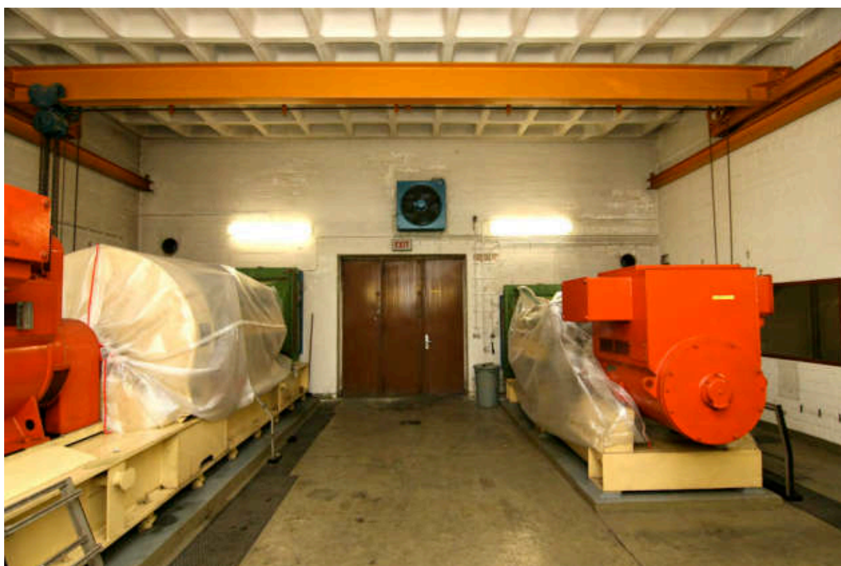
Raum 2, Maschinenraum. Blick auf die Westwand mit Eingangstor TA 2. 2016.
