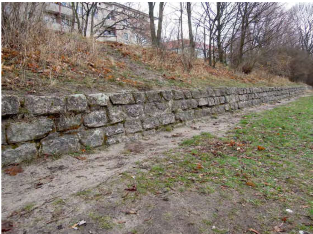
Böschungsmauer, nördlicher Abschnitt bis zur Treppe Kienitzer Straße.
