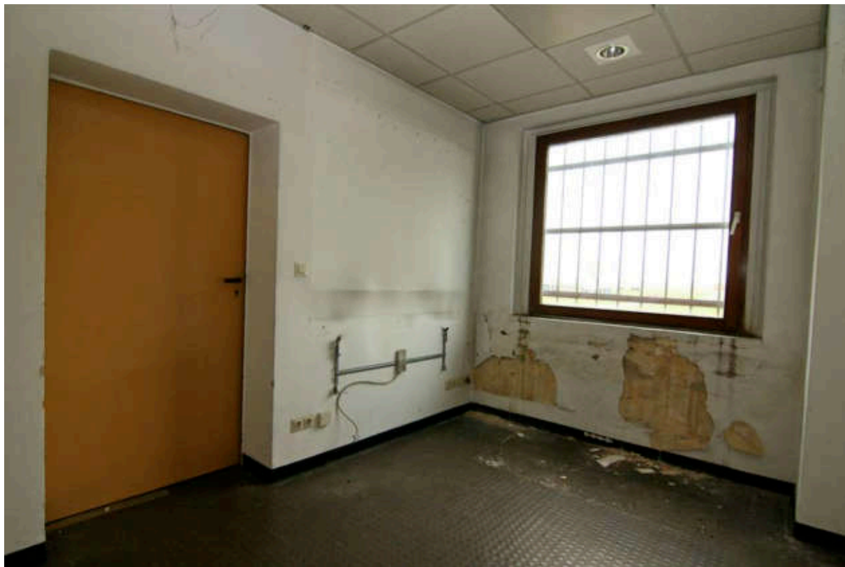
Raum 015, links Stahltür T15 nach Raum 017, rechts Fenster F2.
