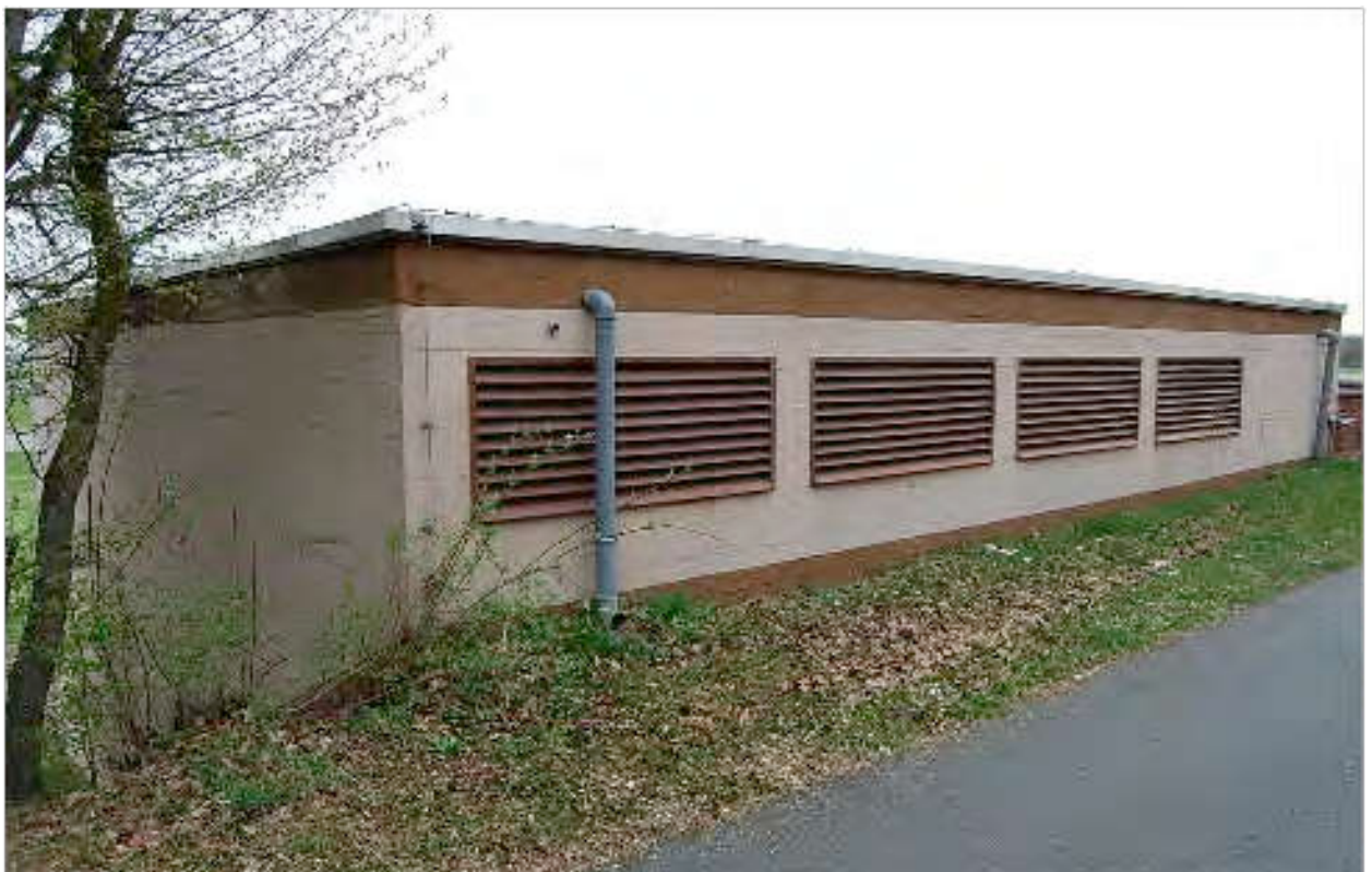
Ostfassade Zustand 2010 (Kurzbericht/Fotodokumentation zur Übernahmebegehung am 15.04.2010, rbv GmbH & Co KG).
