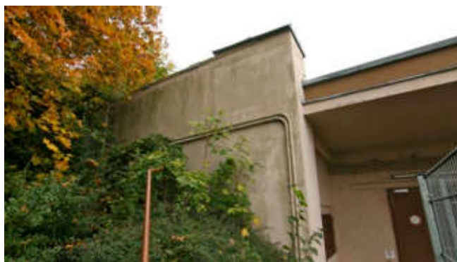
Nordgiebel, höhergeführte Stütz-wand in Stahlbeton. 2016.
