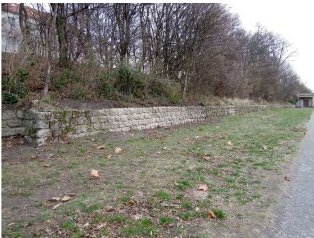
Böschungsmauer, mittlerer Abschnitt, Treppe Kienitzer Straße bis Gebäude 105.
