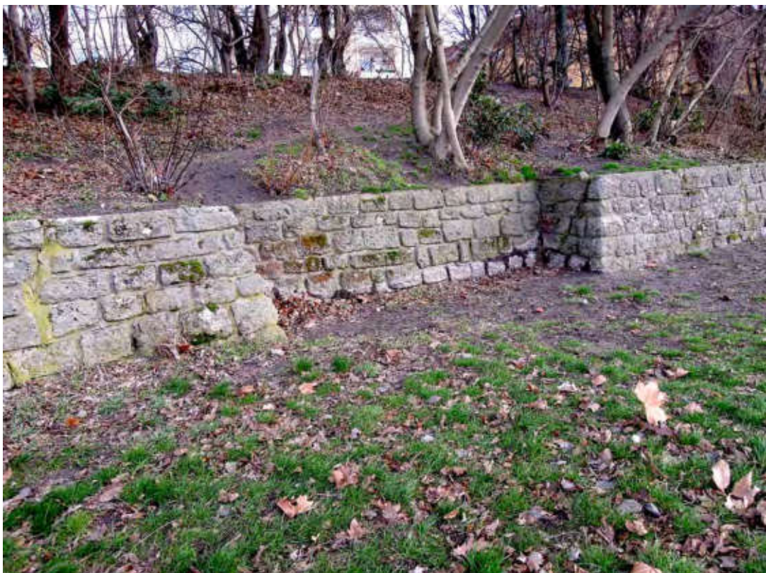
Böschungsmauer südlicher Abschnitt Gebäude 128 bis Gebäude 113, Banknische 5.
