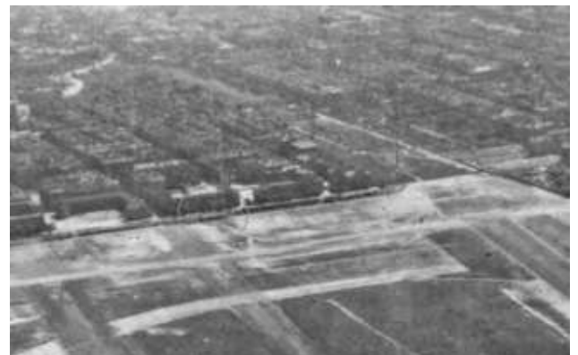
Landebahnen in Bau, um 1948 (Archiv Tempelhof Projekt).
