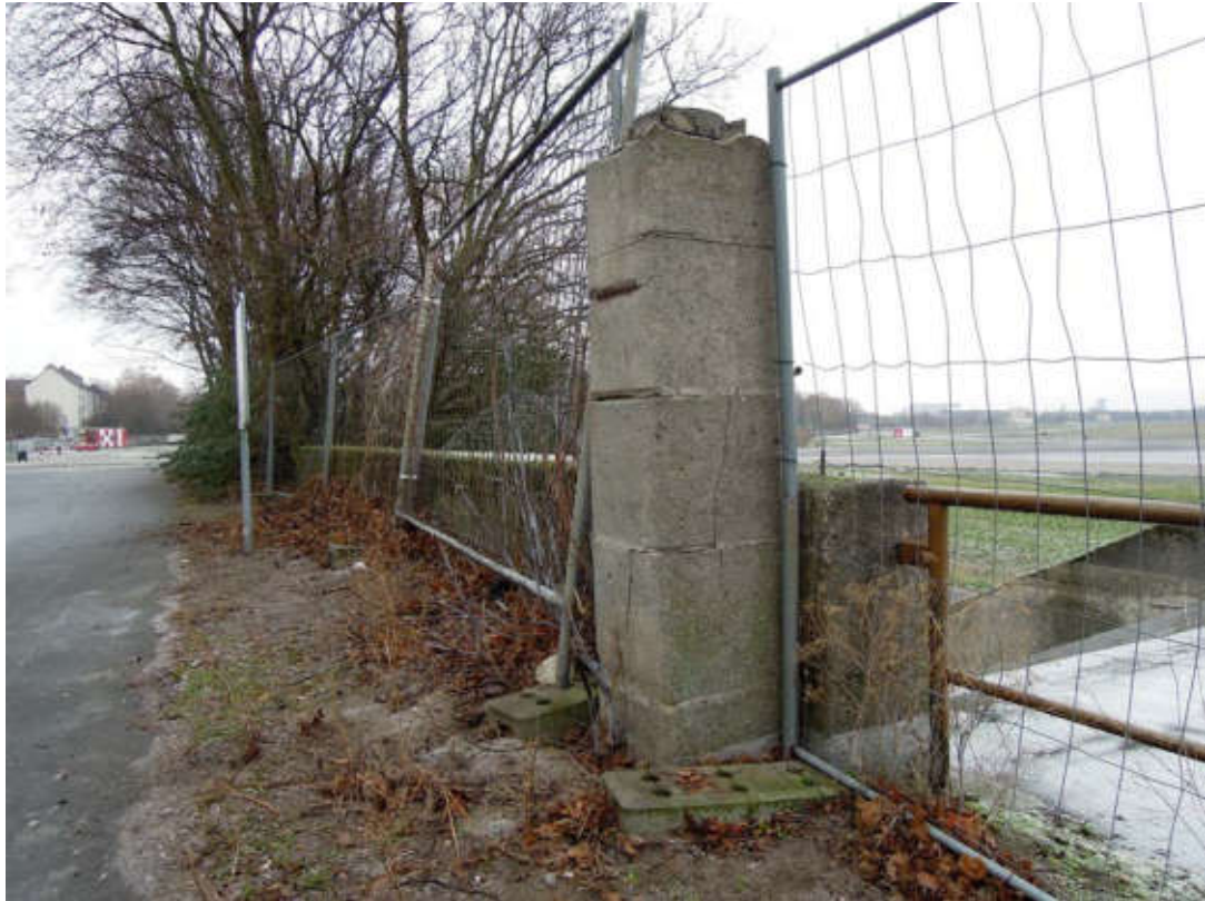
Rest der ursprünglich zwei Betonpylone, ehemals mit Lichtkästen bekrönt, 2019.
