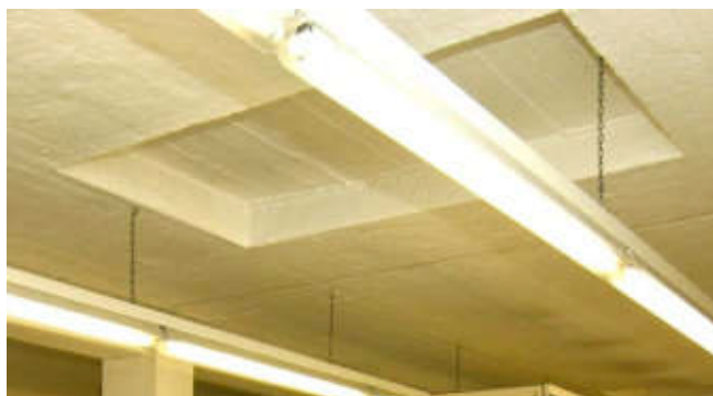
Decke im Raum 003-014, Schalt- u. Traforaum. Aussparung ehemals Oberlicht, Einbau 1948/49. Foto 2106.
