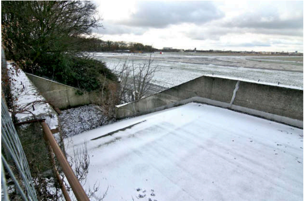
Nördlicher Treppenlauf. Stufen entfernt, Brüstung in Betonkunststein, 2013.
