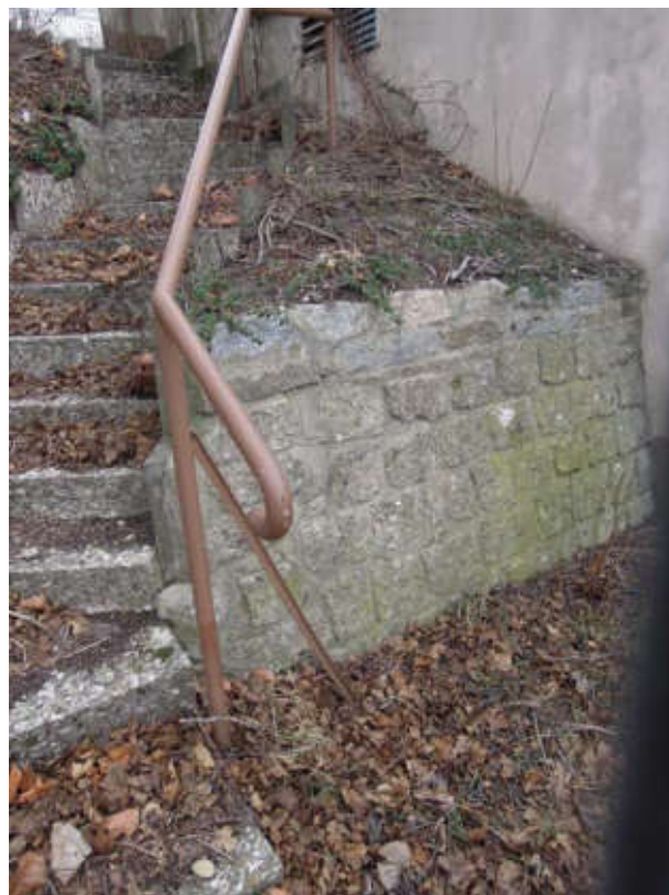
Treppe in die Böschungsmauer eingeschnitten.
