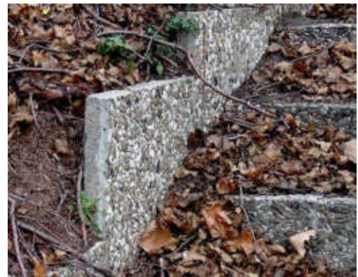
Wangen und Stufen in Waschbeton..
