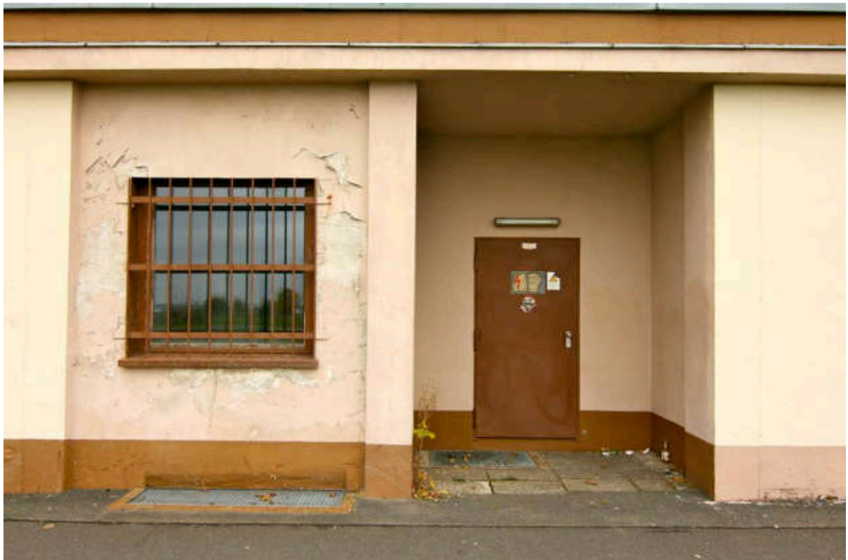
Eingangsbereich Süd, Stahltür TA 2 und Holzfenster F2.
