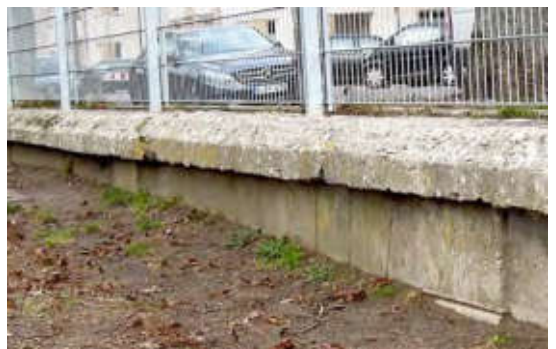
Randstreifen Promenade. Futtermauer von 1906, verputzte Betonmauer u. Kunststein-Deckplatte sichtbar. 2019.
