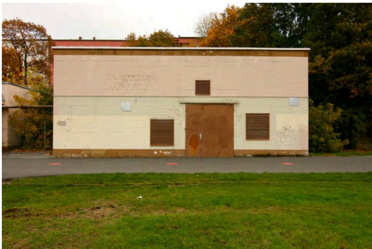
Westfassade, 2016. Stahltor TA 2 und Lüftungslamellenfenster (Abluft).
