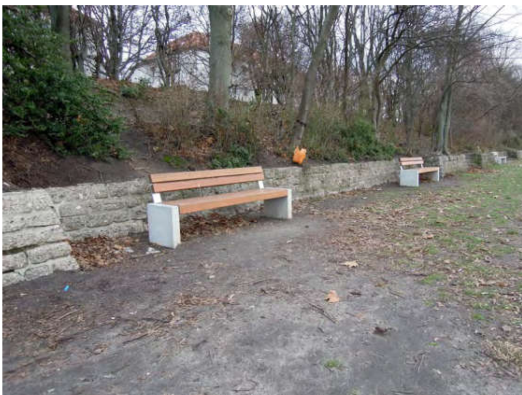
Böschungsmauer, mittlerer Abschnitt, Treppe Kienitzer Straße bis Gebäude 105. Banknischen 1 bis 3.
