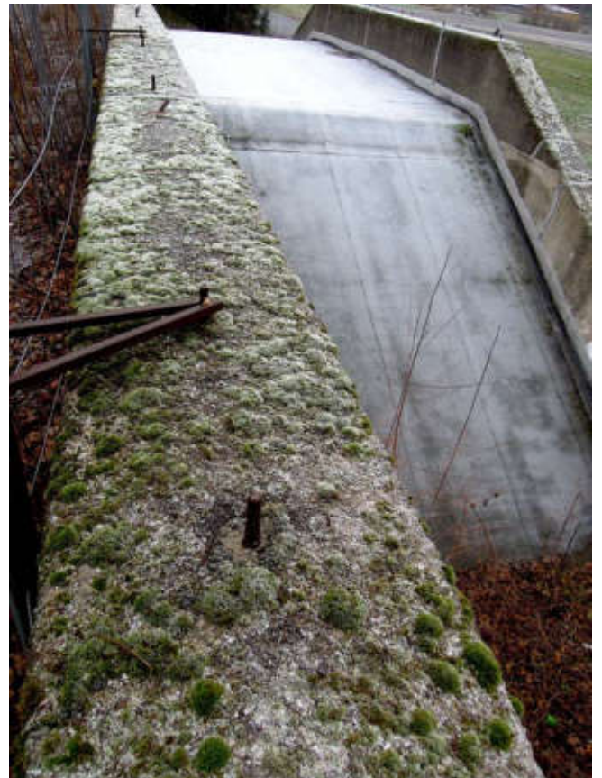
Brüstungsmauer, Ebene Oderstraße. Ehemals geschmückt mit Blumenkästen. Armierungseisen zu ihrer Befestigung, 2019.
