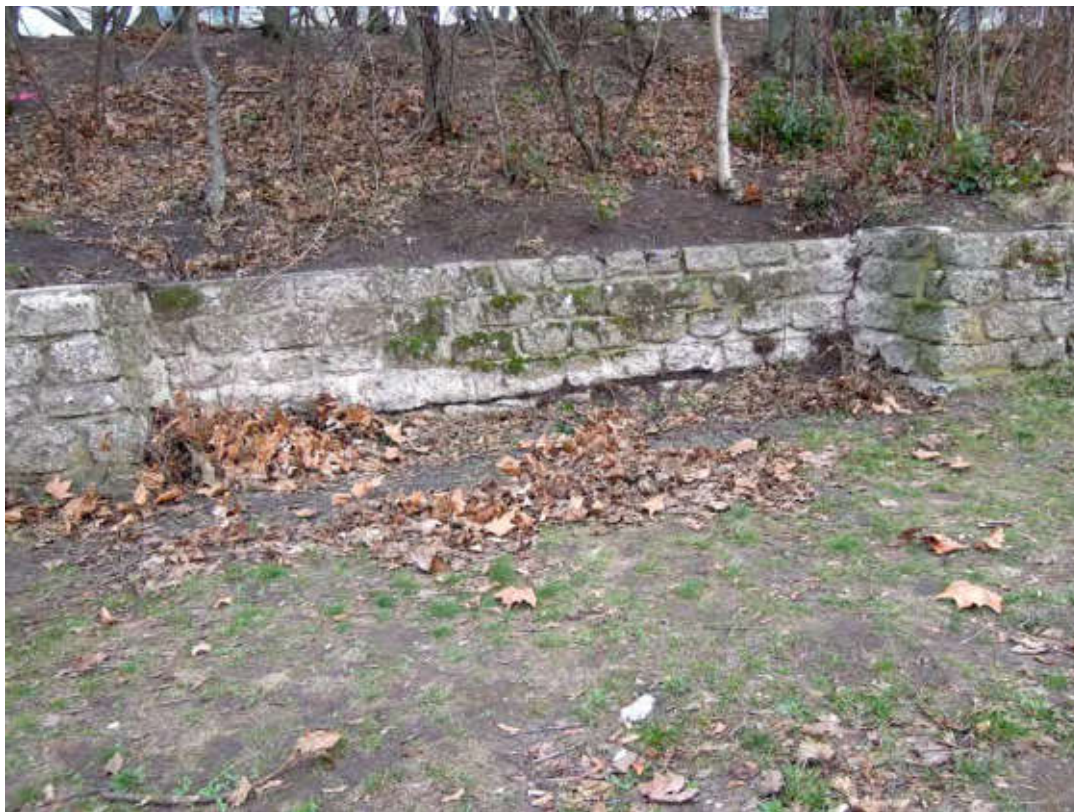
Böschungsmauer, mittlerer Abschnitt, Treppe Kienitzer Straße bis Gebäude 105. Banknische 2.
