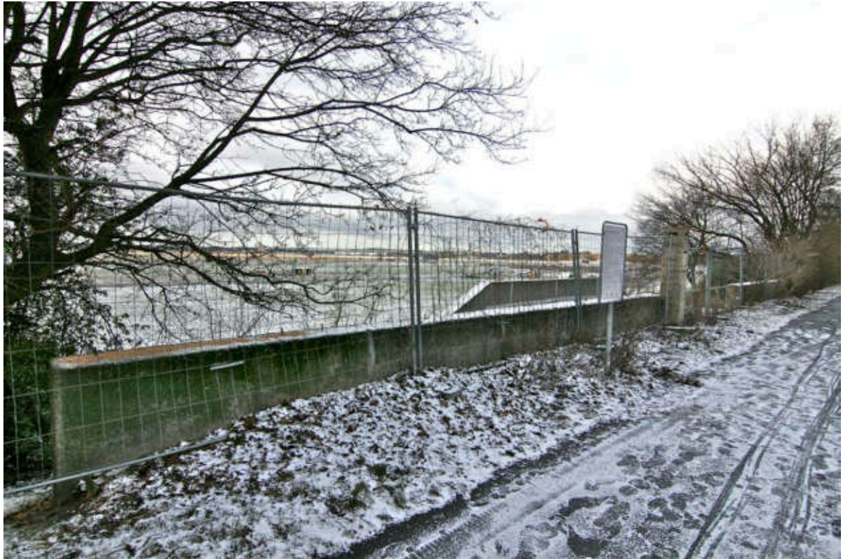
Brüstung der Stützmauer entlang der Oderstraße, 2013.
