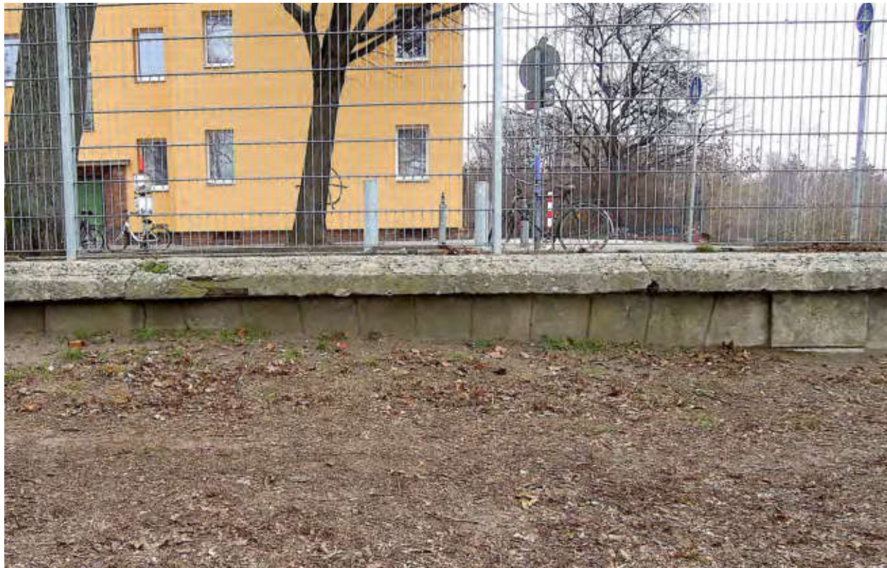
Promenade, südliches Ende. Randbegrenzung, Futtermauer von 1906. Sichtbarer historisierender Verputz zwischen den Pfeilern.
