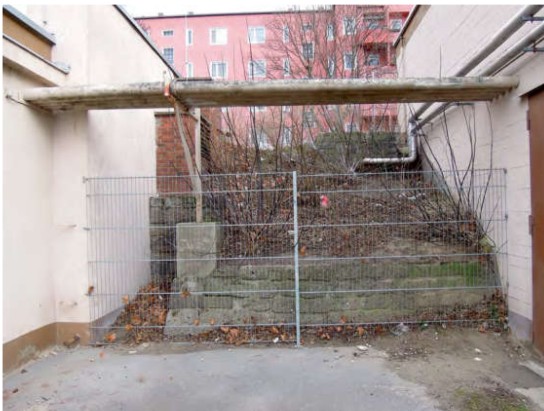
Böschungsmauer. Rest der Mauer zwischen Gebäude 105 und Gebäude 128.
