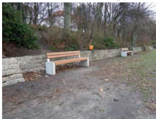
Böschungsmauer, erhaltene Banknischen, 2019.
