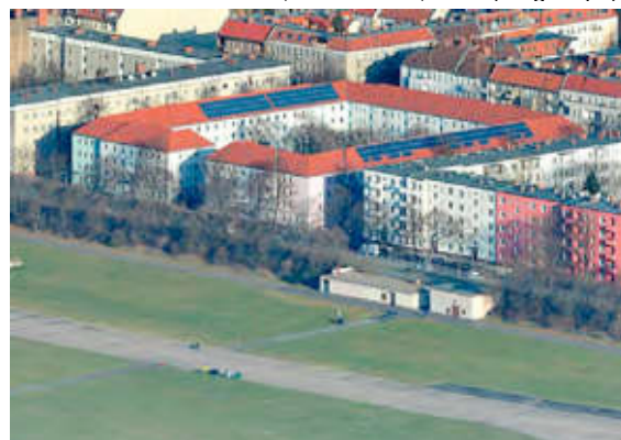
Rechts Generatorenstation von Westen, 2011.
