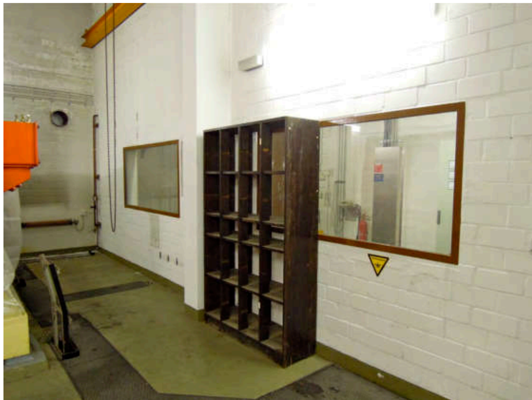
Raum 2, Maschinenraum. Nordwand mit Überwachungsfenster vom Schalraum F110/F11. 2016.
