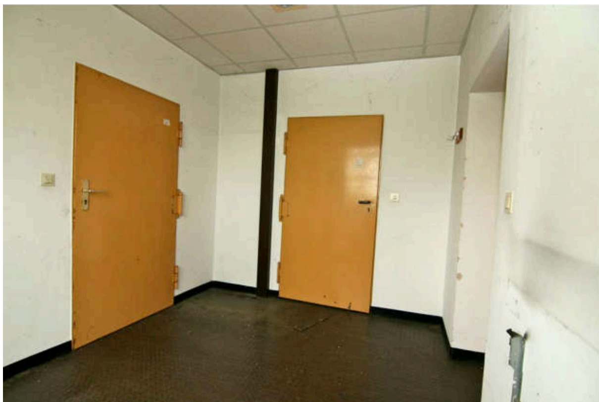
Raum 015, links Stahltür T13 nach Raum 003-004, rechts Stahltür T14 nach Raum 016
