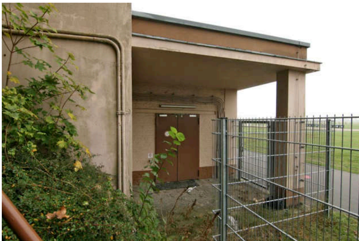
Eingangsbereich Nord, Stahltür TA 1.
