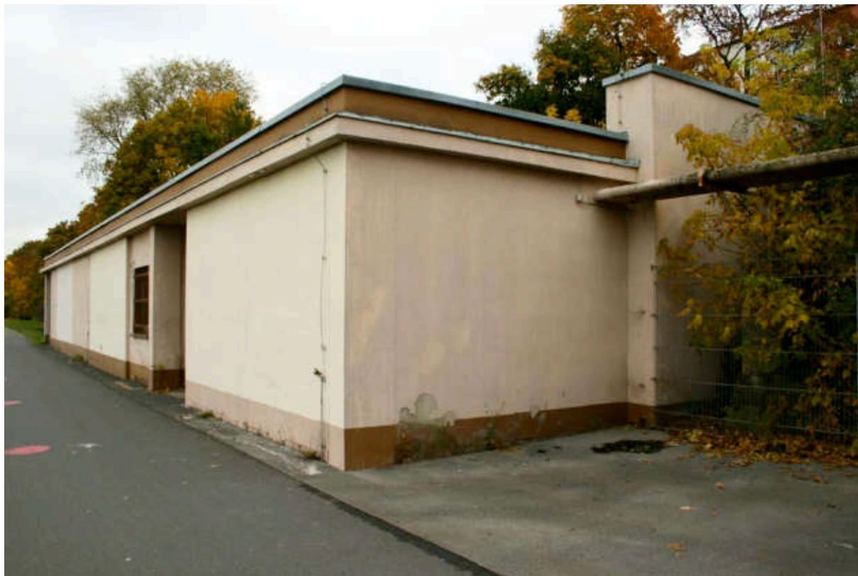
Blick von Südosten, im Vordergrund Trafostation.
