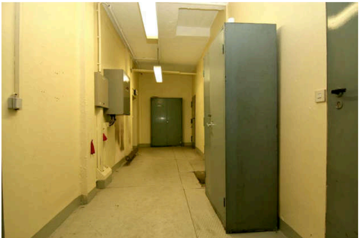
Raum 018a-022a, Flur. Blick nach Norden. Im Hintergrund Stahlschrank anstelle Tür.
