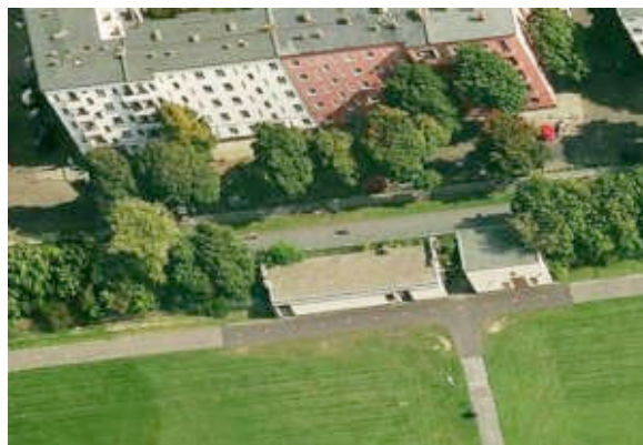
Rechts Generatorenstation, von Westen, 2013 (Bing Maps).
