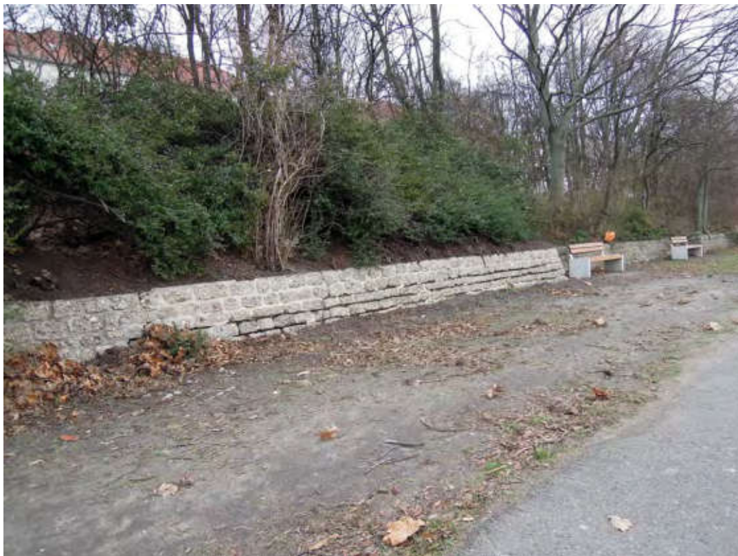
Böschungsmauer, mittlerer Abschnitt, Treppe Kienitzer Straße bis Gebäude 105 mit Banknischen.
