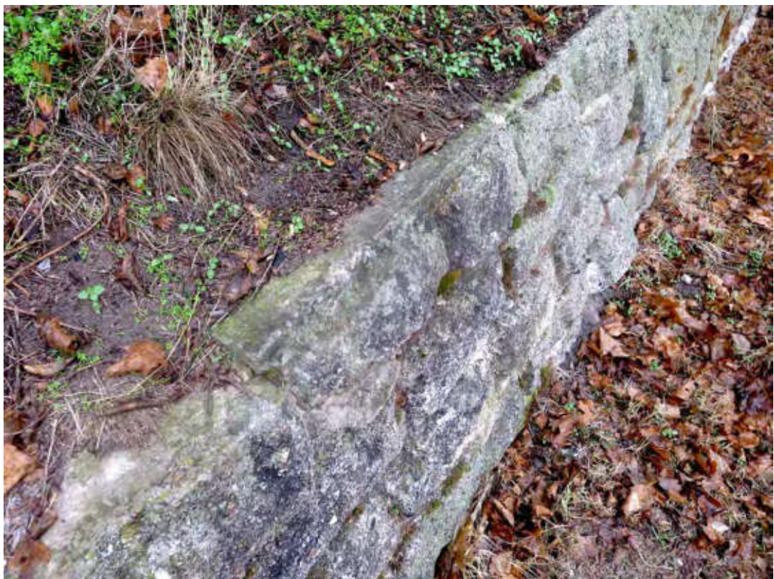
Böschungsmauerwerk, Mörtelreste der Abdeckung, ehem. Kunststeinplatten.
