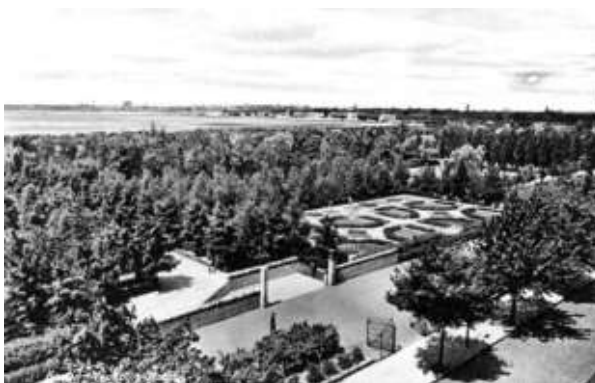
Zugangstreppe zum Sportpark Neukölln auf Höhe der Leine- straße, 1935 (Foto: Landesarchiv Berlin).
