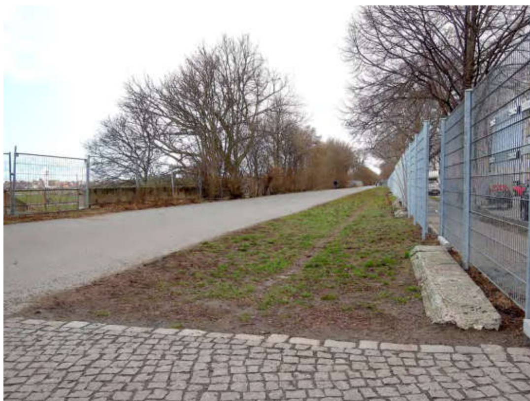
Promenade, Rest der Randbegrenzung, Mauerkrone der Futtermuer von 1906.
