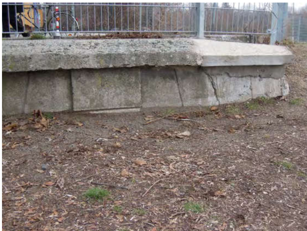
Randbegrenzung südliches Ende, Futtermauer von 1906. Pfeiler mit Putzfuge.
