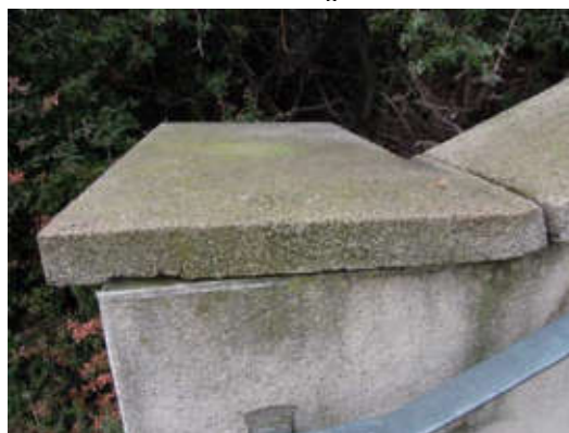
Bauzeitliche Kunststeinplatte aus der Verankerung.
