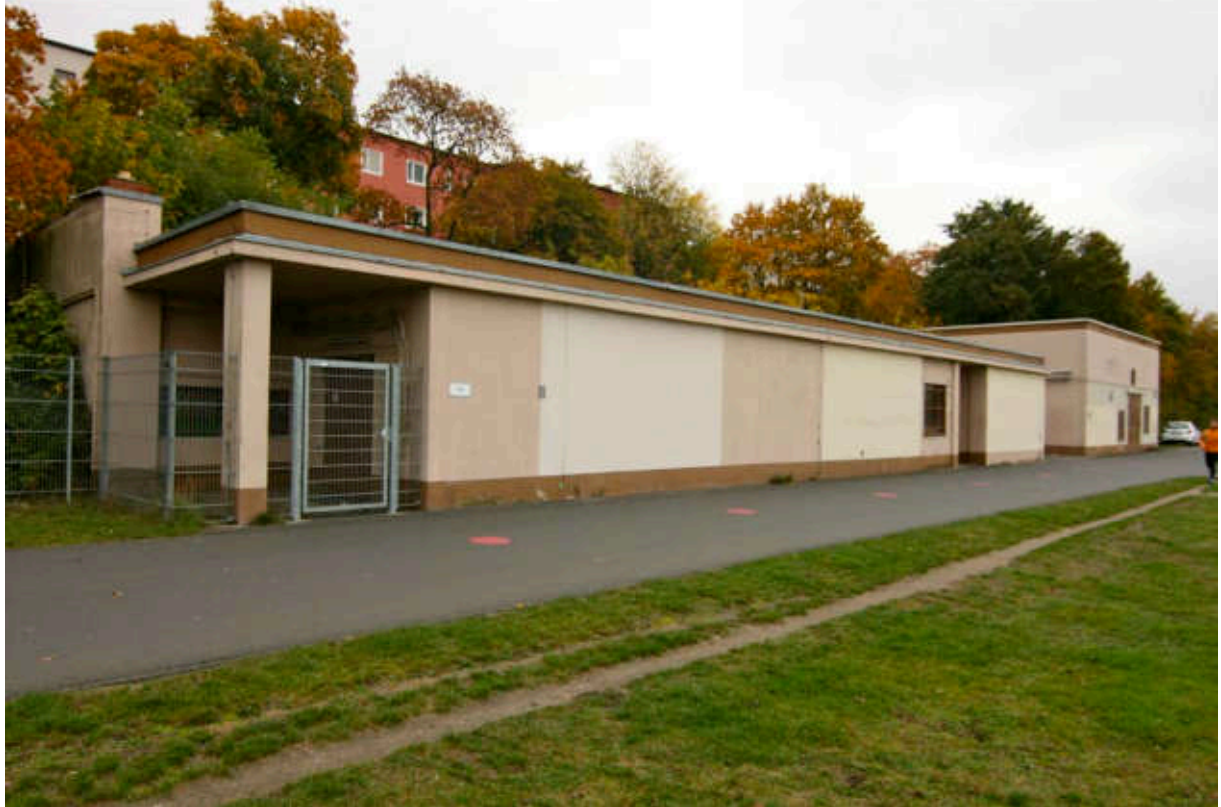
Blick von Nordosten, im Vordergrund Trafostation, Gebäude 105.
