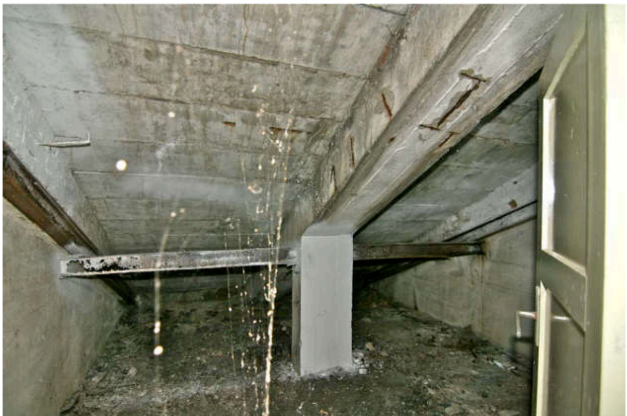
Raum 4, Raum unterhalb des nördlichen Treppenlaufes, Eisenbetonkonstruktion.
