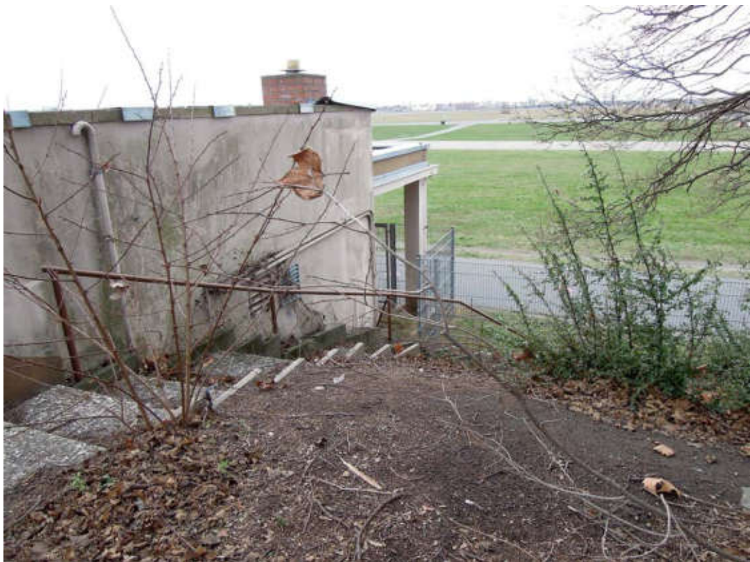
Oberhalb der Böschung, Ebene Oderstraße.
