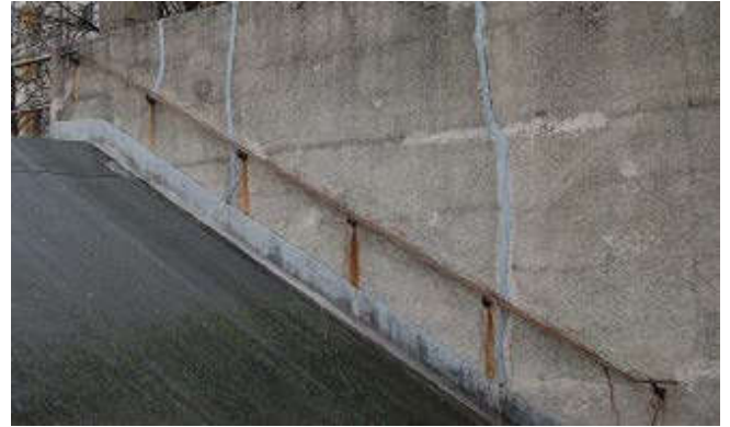
Handlauf beim nördlichen ehemaligen Treppenlauf, 2010.
