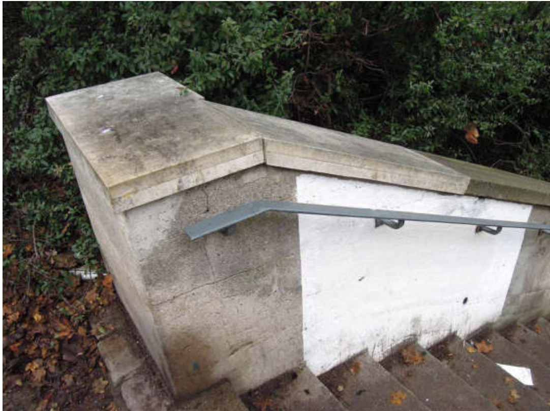
Bauzeitliche und erneuerte Kunststeinabdeckung der Brüstung.
