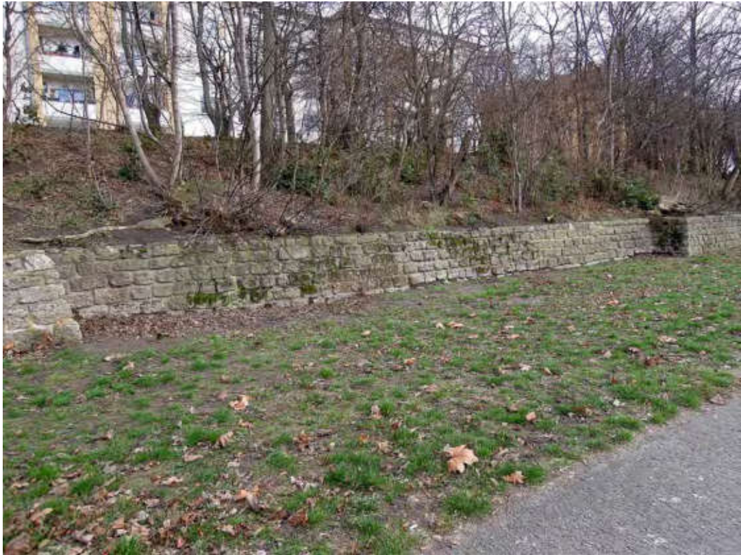
Böschungsmauer südlicher Abschnitt Gebäude 128 bis Gebäude 113, Banknische 4.
