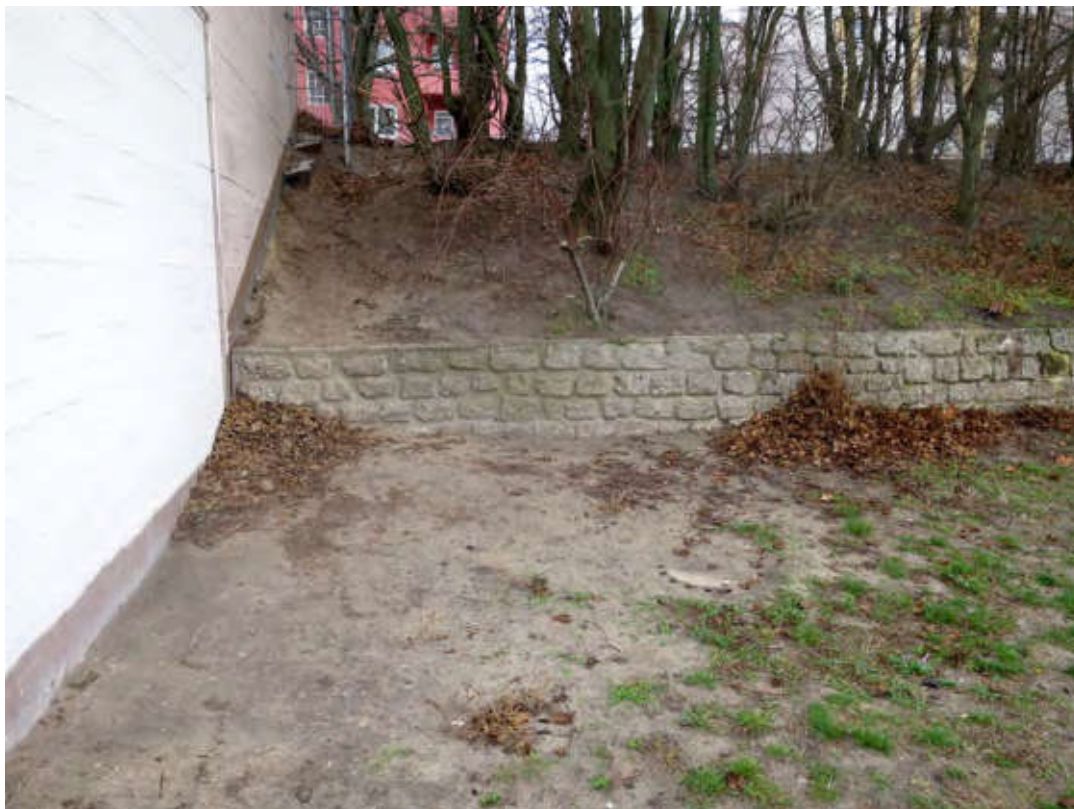
Böschungsmauer auf der Südseite des Gebäudes 128.
