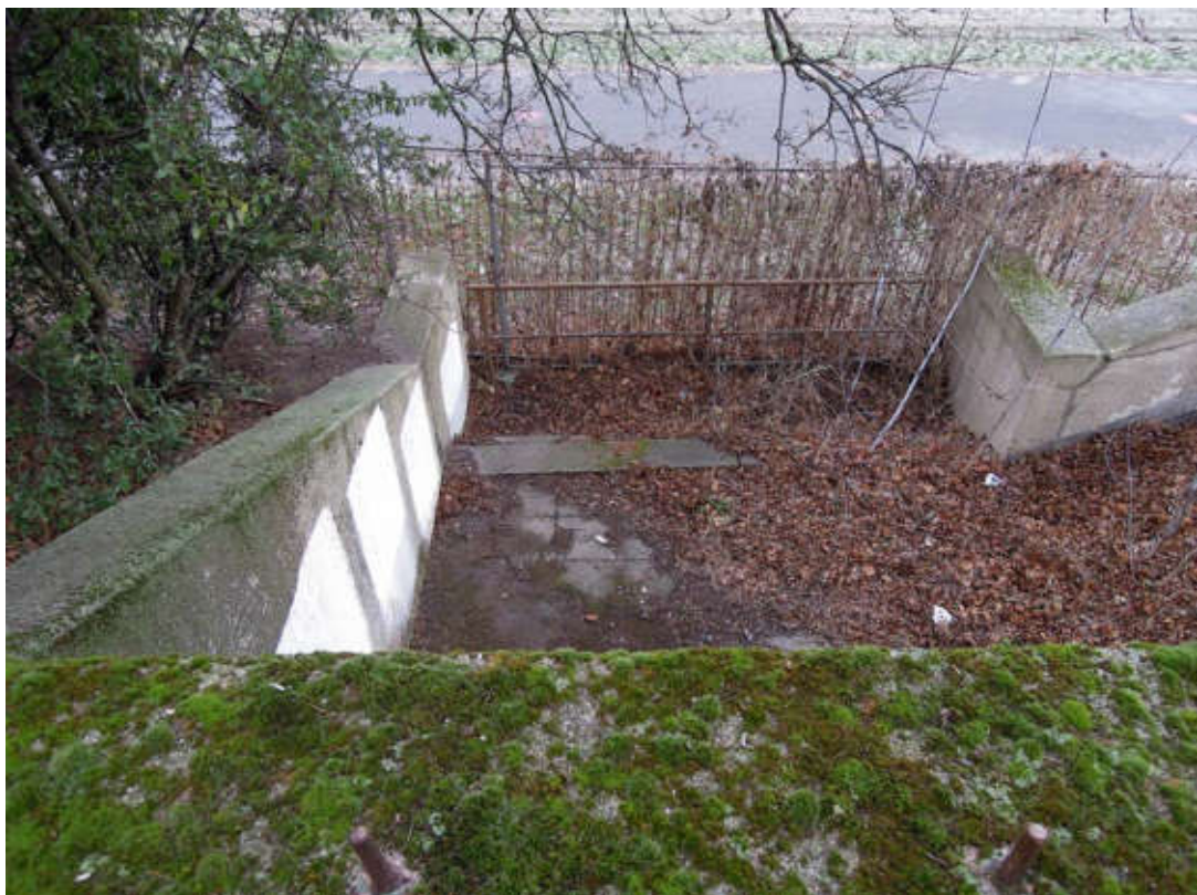
Südlicher Treppenlauf, Brüstung, 2019
