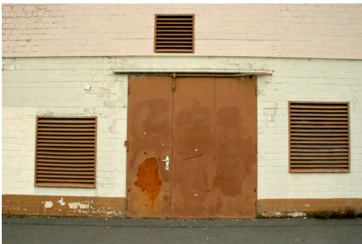
Westfassade, 2016. Stahltür TA 2 und Lüftungslamellenfenster, unten F1/F2 (alle Abluft).
