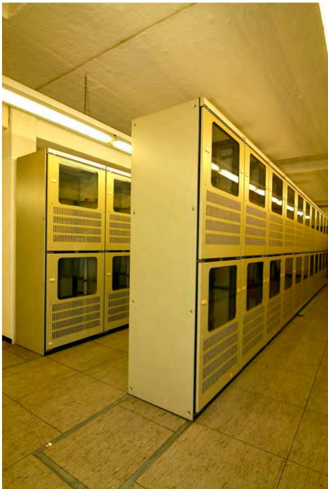
Raum 003-004, Siemens-Einzeltrafos für die Niederspannungs-Befehung der Lande- und Startbahnen.
