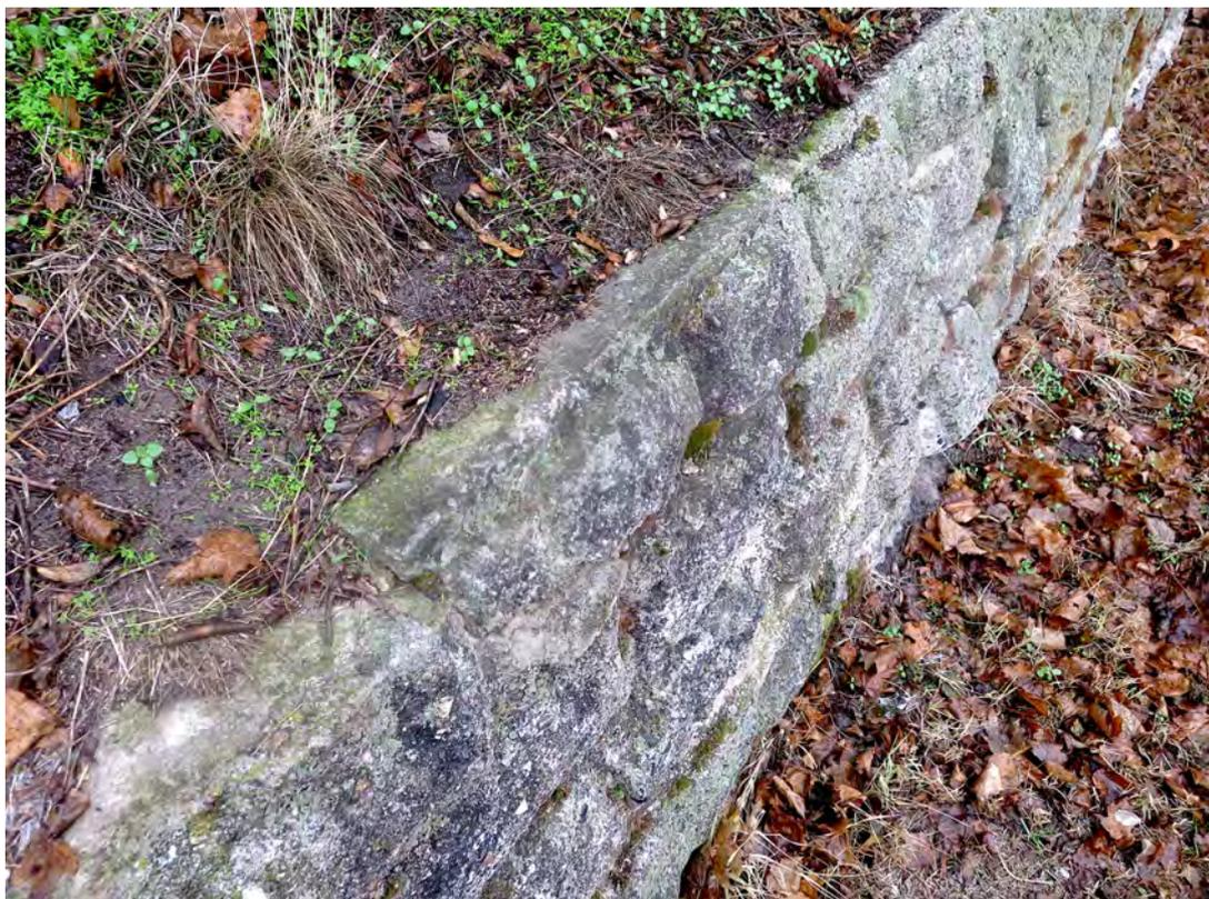
Böschungsmauerwerk, Mörtelreste der Abdeckung, ehem. Kunststeinplatten.
