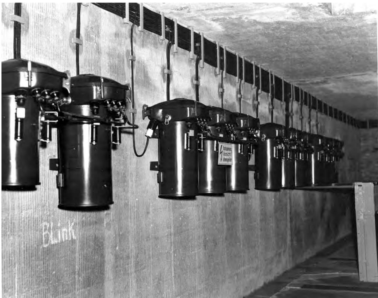
BILDINHALT Tafos in der zur Generator-Station umgebauten ehem. Unterstandshalle.
