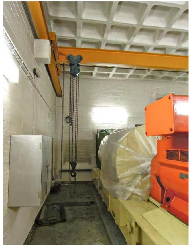
Raum 2, Maschinenraum. Kranbahn Tragkraft 5t., 2016.
