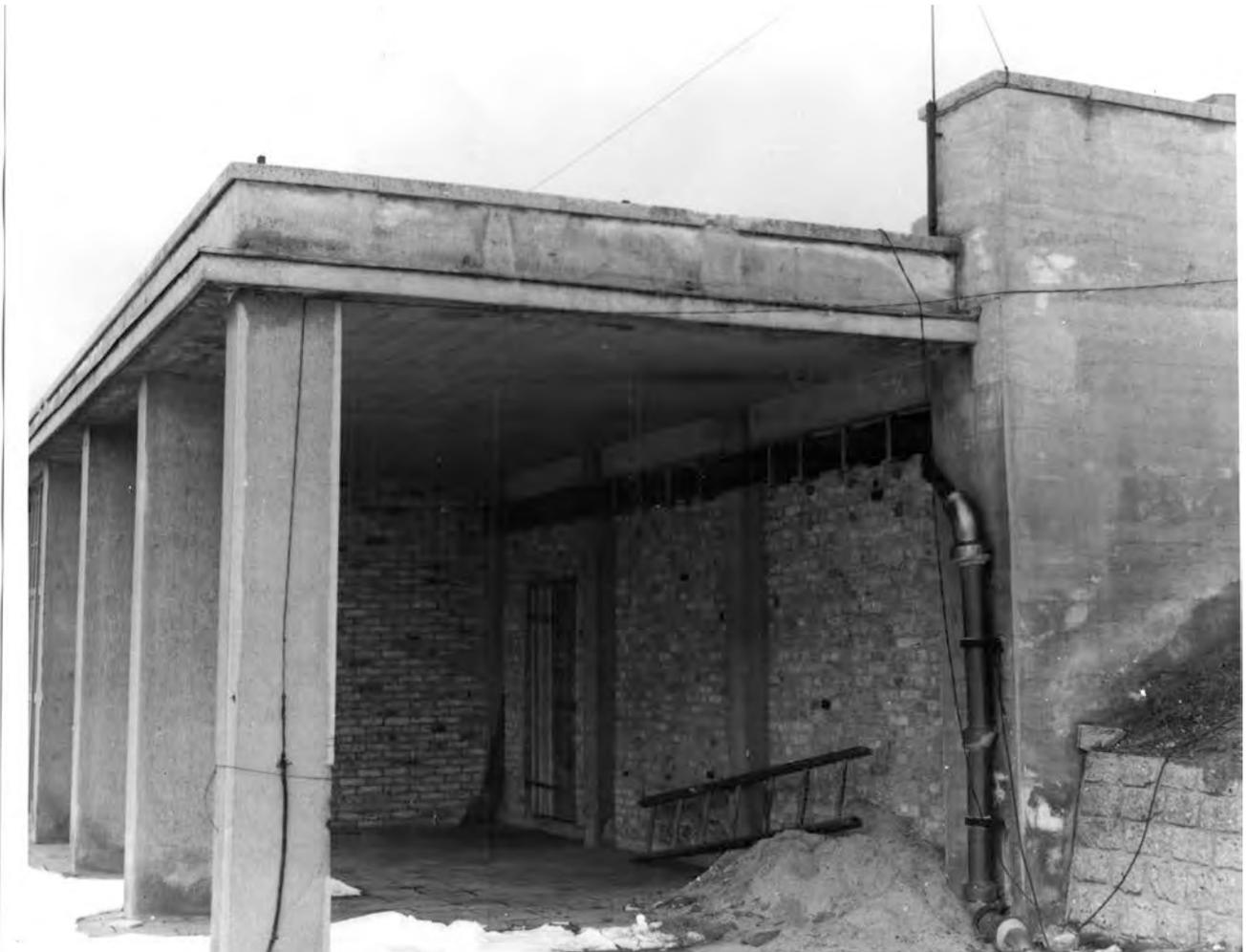
**BILDINHALT** Die zur Generator-Station umgebaute ehem. Unterstandshalle.
