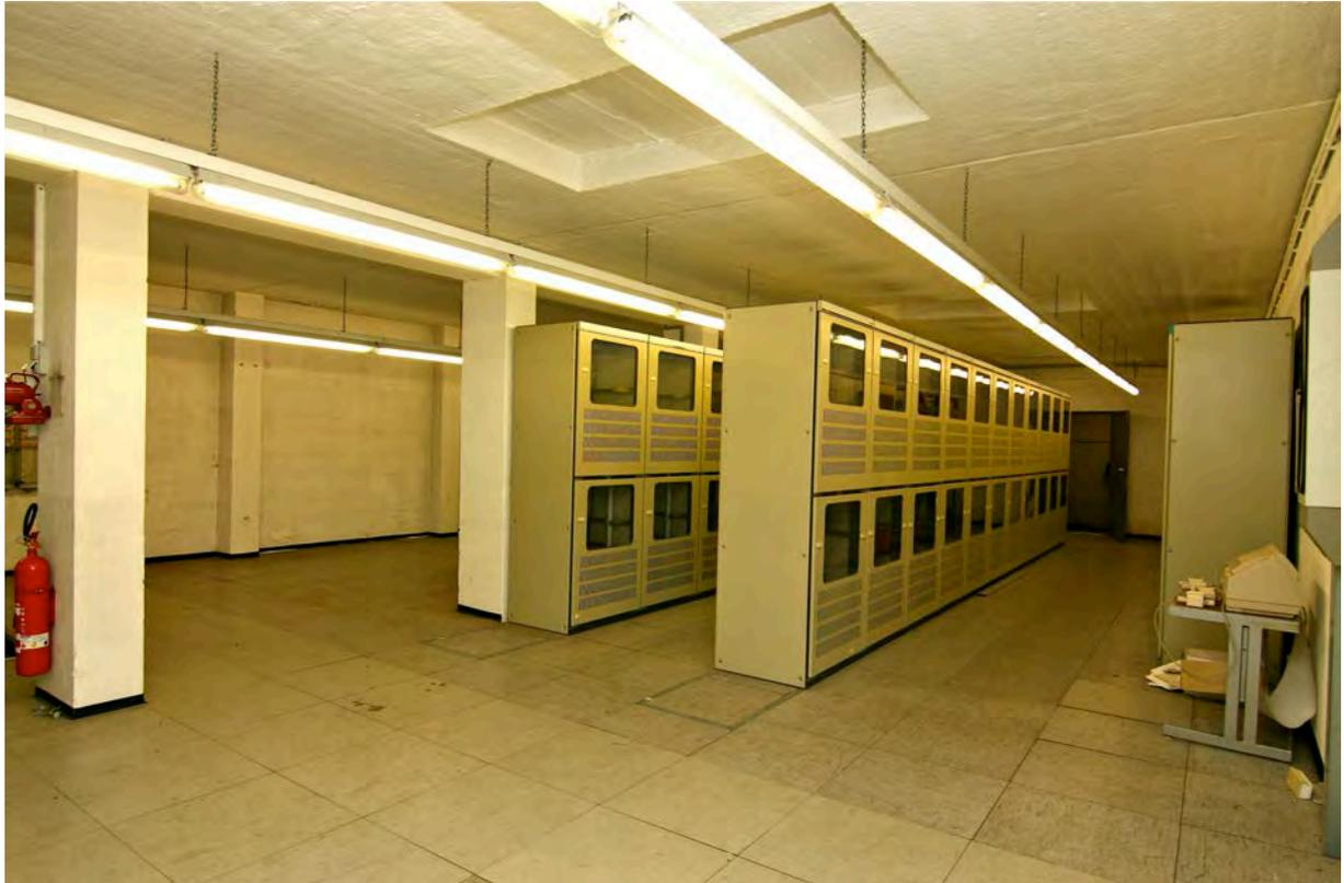
Raum 003-014, Schaltraum Befeuerung der Start- und Landebahnen. Einzeltrafos zur Steuerung der Flugfeldleuchten.
