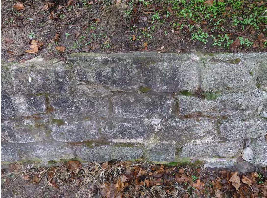
Böschungsmauerwerk aus Betonkunststeinen in Bruchsteinoptik.
