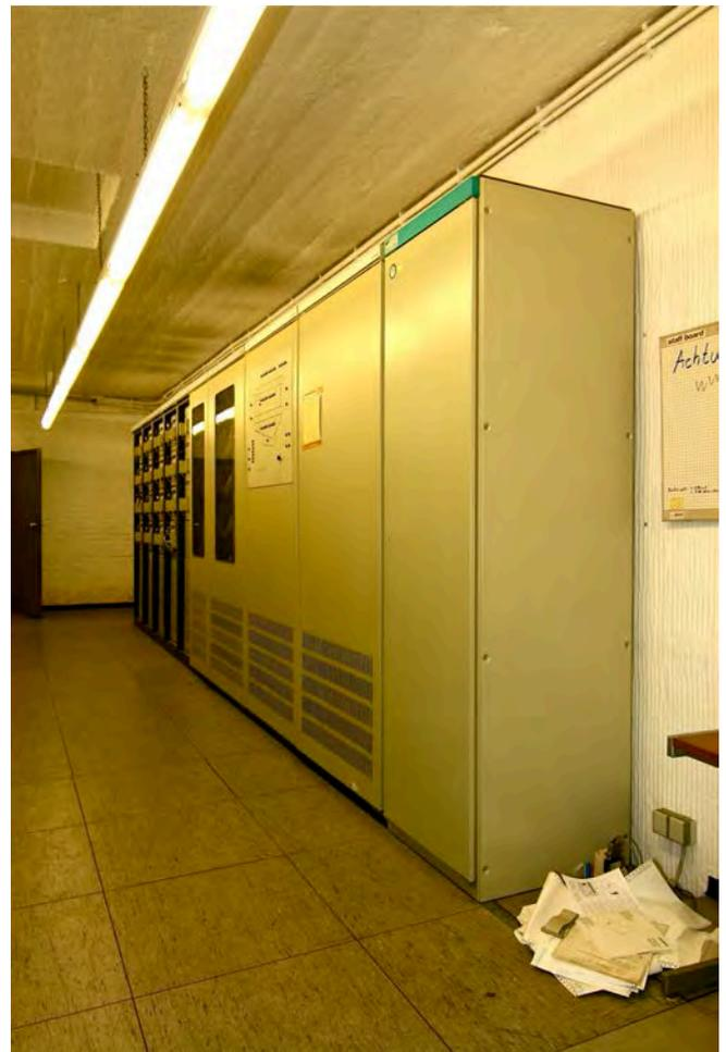
Raum 003-004, Siemens Schaltanlage für die Befehung der Lande- und Startbahnen.
