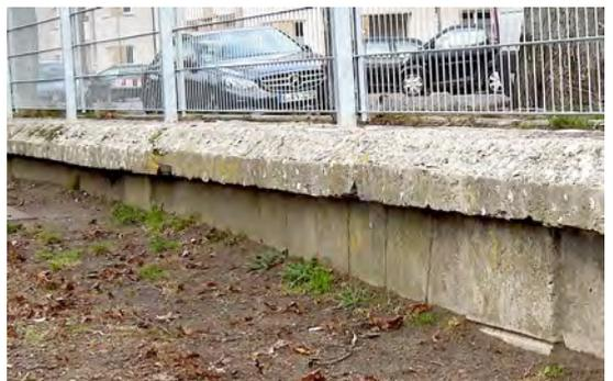
Randstreifen Promenade. Futtermauer von 1906, verputzte Betonmauer u. Kunststein-Deckplatte sichtbar. 2019.
