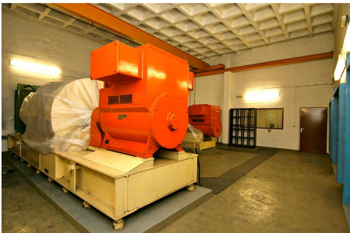
Raum 2, Maschinenraum. Vordergrund Schnellbereitschafts-Generator, Hintergrund Notstrom-Generator, rechts TI 1. 2016.
