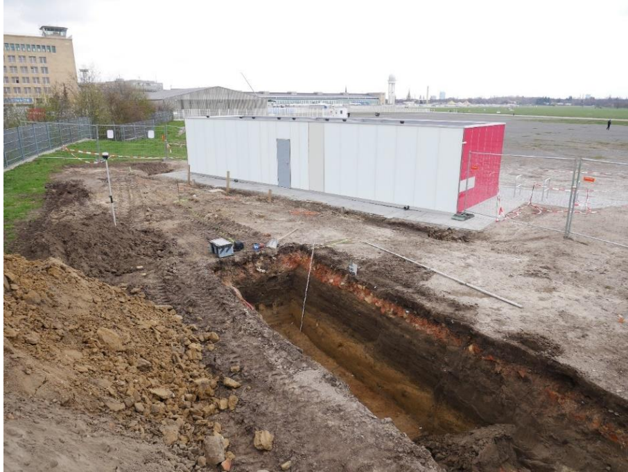
Abb. 21: BTF, Überblick über die Verladerampe mit Planierschicht und Unterbauschichten (Foto: G. H. Jeute).
