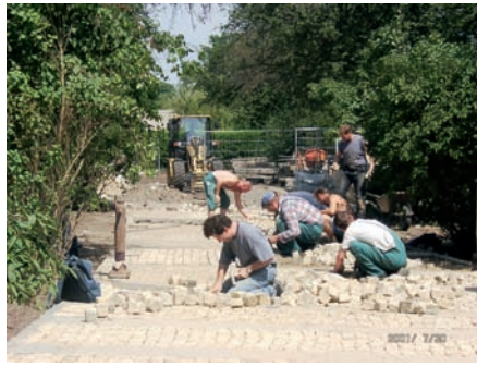
QM Soldiner Strasse: Bauarbeiten La Piazzetta
