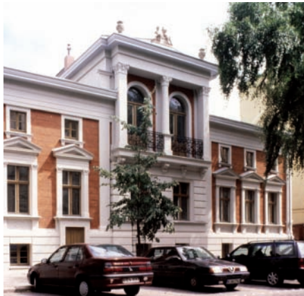
Villa Schott, Straßenfassade und Hofansicht
