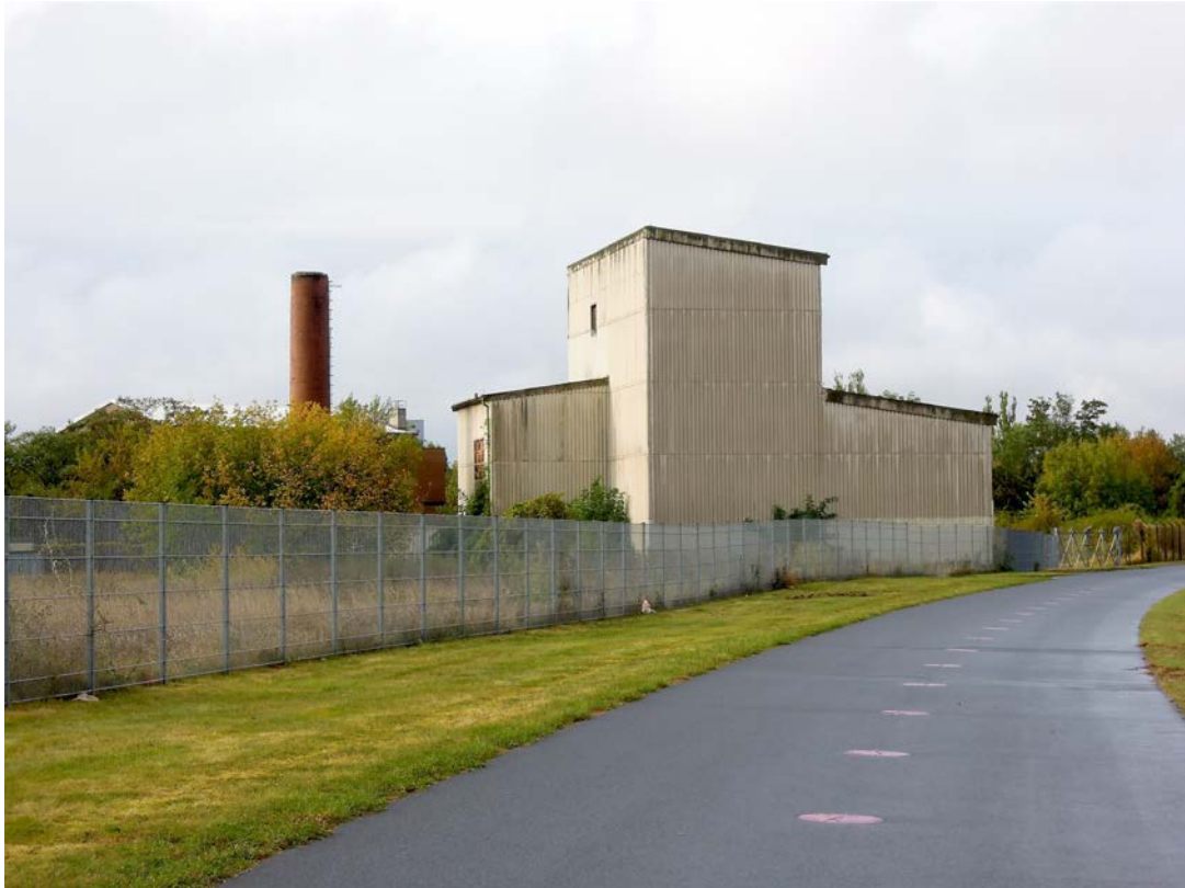
Blick von Norden, von der Umfahrtsstraße.
