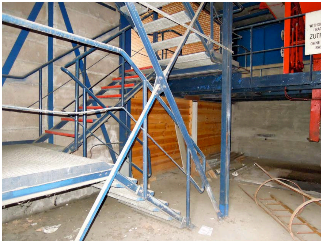
EG, Hallenraum 3. Stahltreppe-Anfang. Im Hintergrund nachträgliche Holz-Trennwand nach ehem. Aschesilo.
