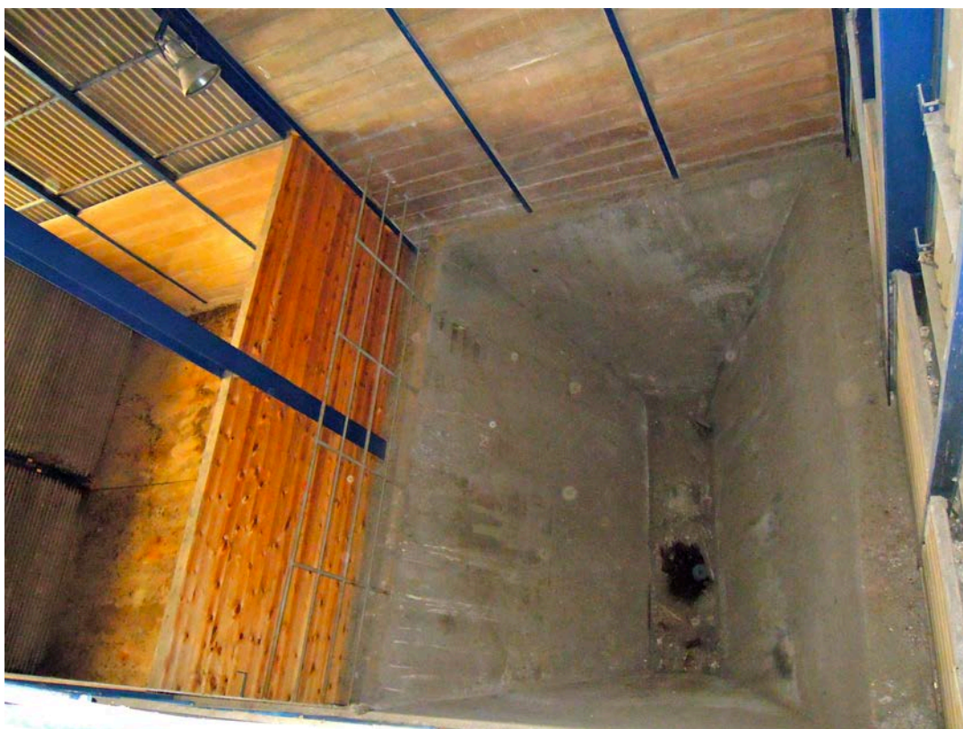
EG, Hallenraum 6, Müllbunker, links Hallenraum 5, Standplatz Müllfahrzeuge, nachträgliche Holz-Trennwände.
