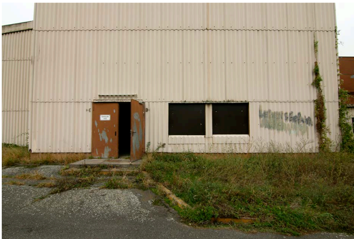
Halleneingang TA1 und Fenster Personalräume F1 und F2.
