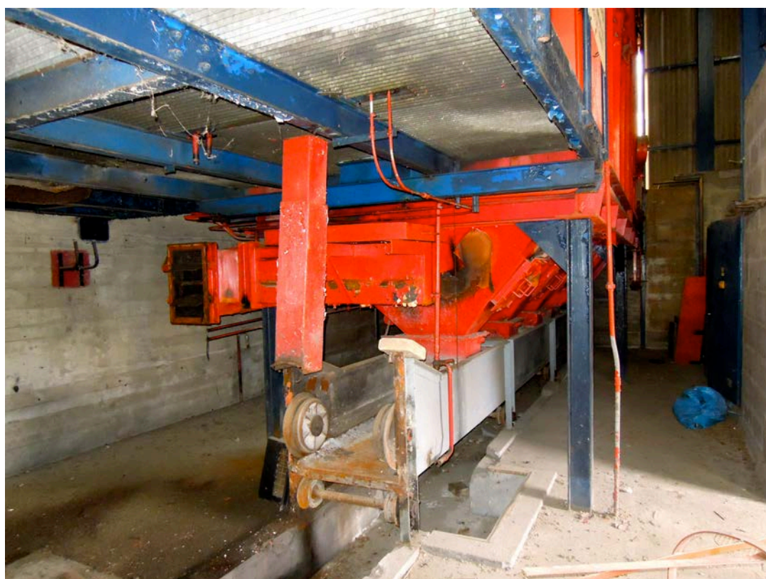
EG, Hallenraum 3. Ofen, Aschetrichter und Naschenkratzer der Asche (unten), abgebrochen.
