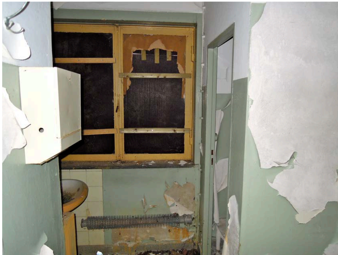
Massiver Einbau für Personalräume. Waschraum 2.
