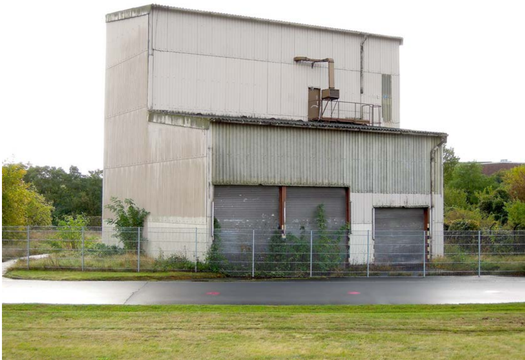
Westseite mit den Stahlrolltoren für Müll- und Aschefahrzeuge.
