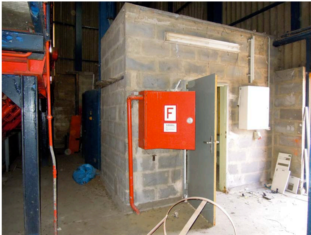
Hallenraum 3. Massiver Einbau für Personalräume. Tür TI 1.
