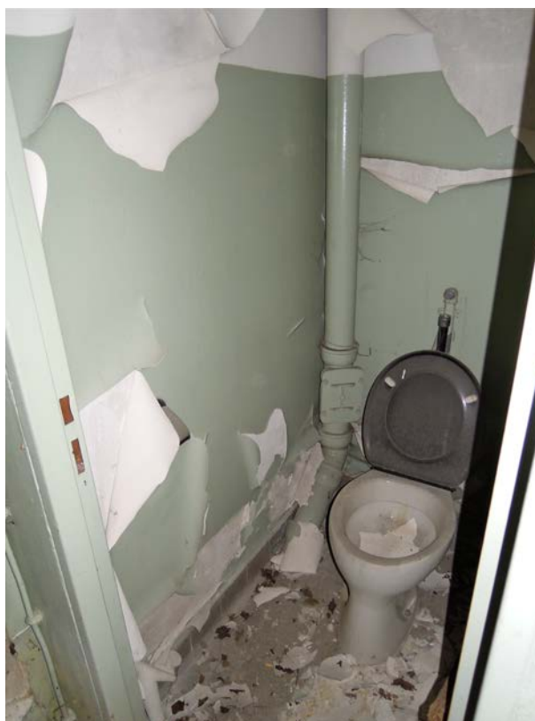
Massiver Einbau für Personalräume. WC Raum 2.
