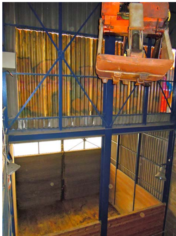
Blick von Arbeitsbühne Ebene 3 nach Einfahrtstor Müllfahrzeug.
