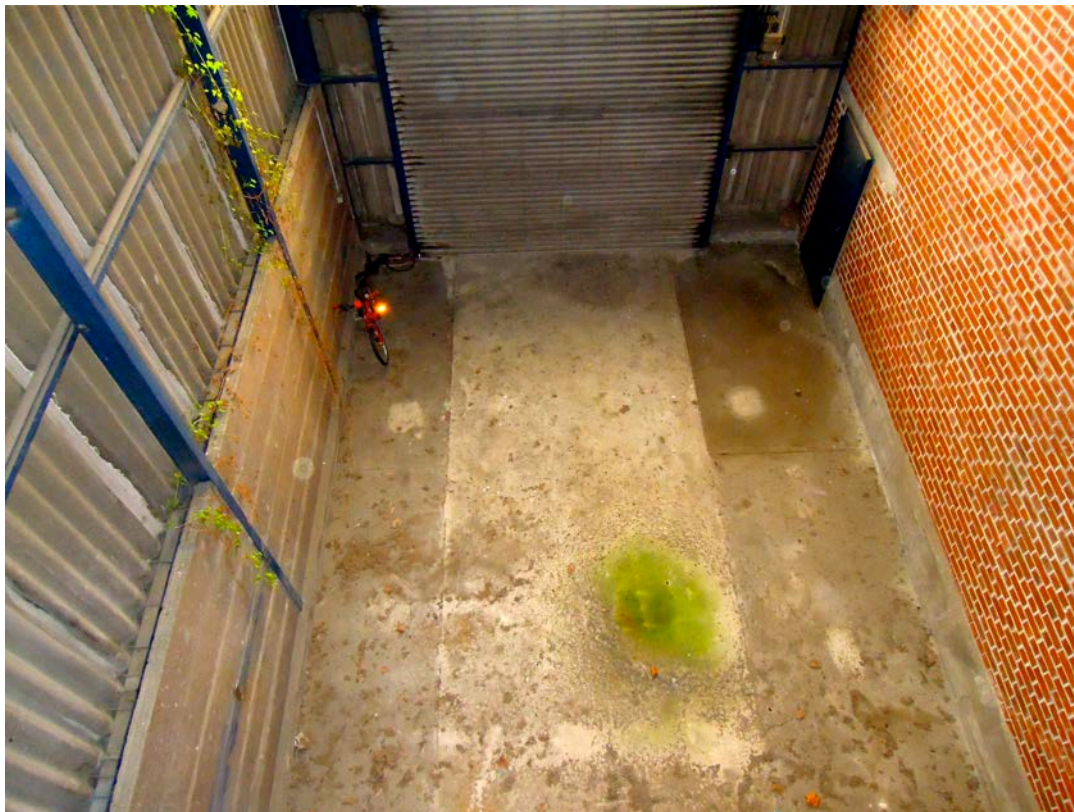
EG, Hallenraum 4. Ehem. Aschesilo. Rolltor-Einfahrt.
