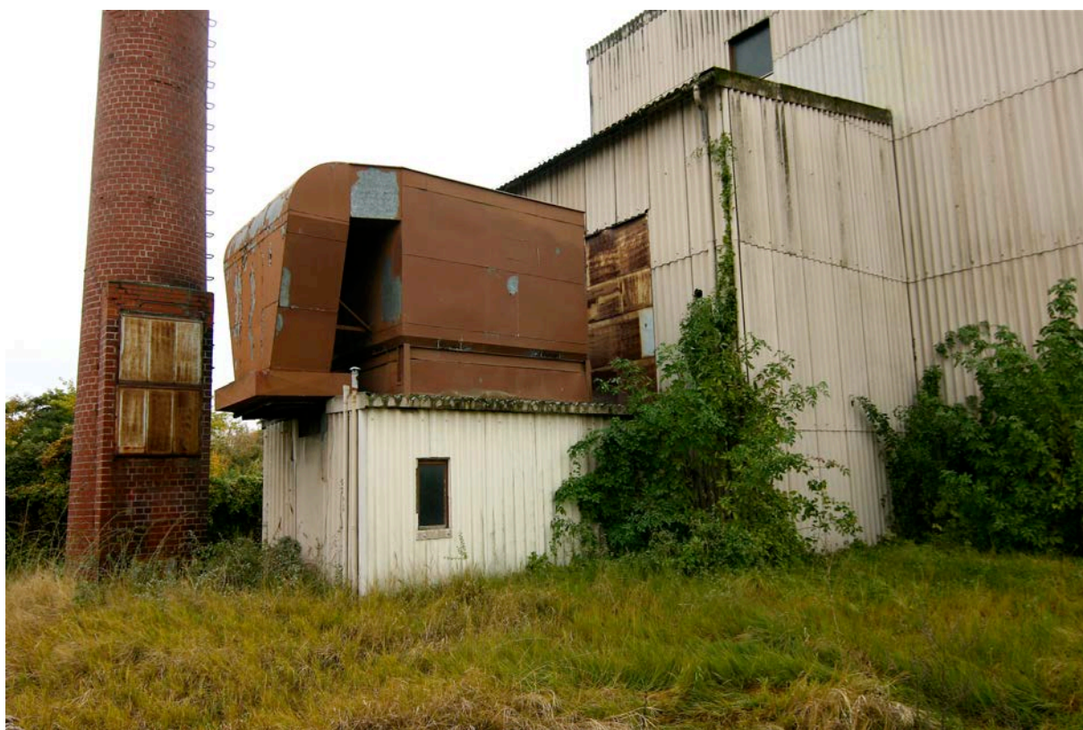
Reste der Rauchreinigungs- und Entstaubungsanlage. Schornstein.
