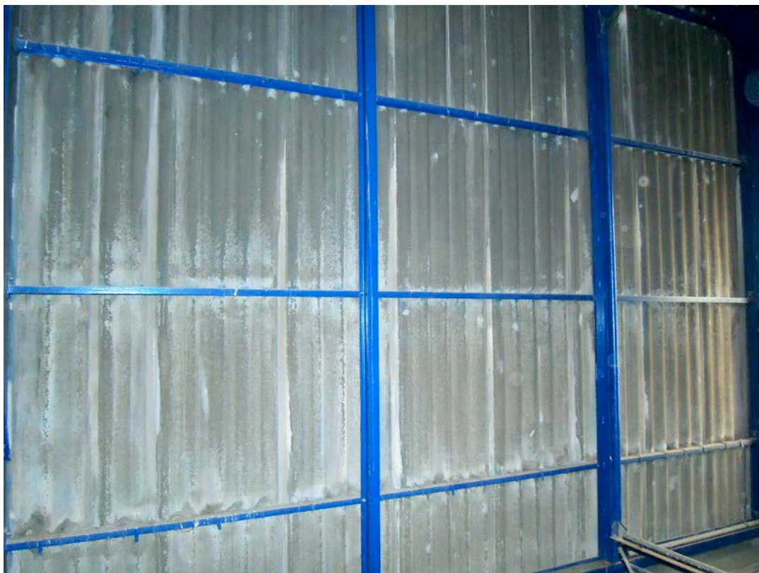
Arbeitsbühne Ebene 3. Außenwand Ost, Stahlskelett und Asbest-Wellplattenverkleidung.
