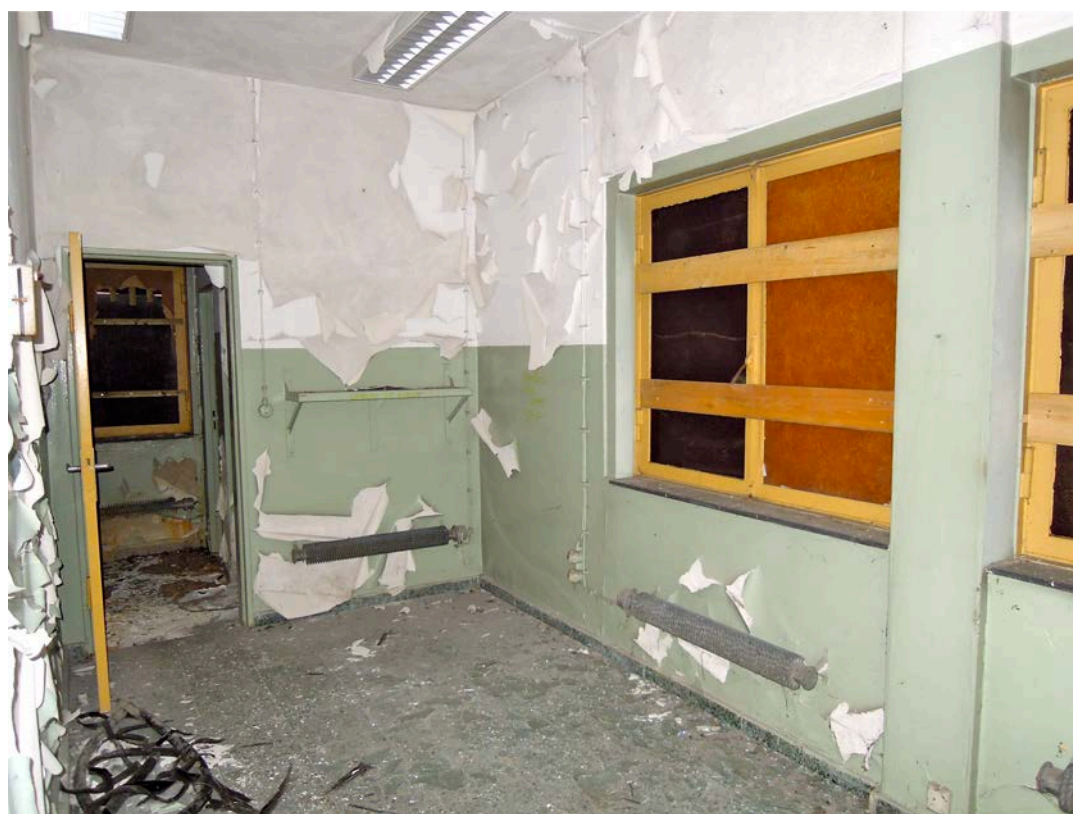
Massiver Einbau für Personalräume. Aufenthaltsraum 1, Tür TI 2 nach Wasch- und WC-Räumen.
