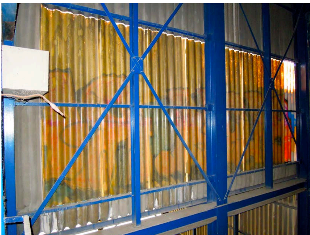
Arbeitsbühne Ebene 3. Außenwand West, Stahlskelett und lichtdurchlässige Wellplattenverkleidung.
