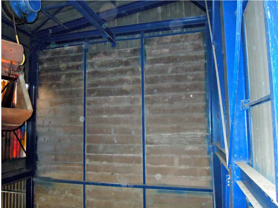
Arbeitsbühne Ebene 3. Außenwand Nord, Stahlskelett-Fachwerk und Ausfachung mit Beton-Fertigteileplatten.
