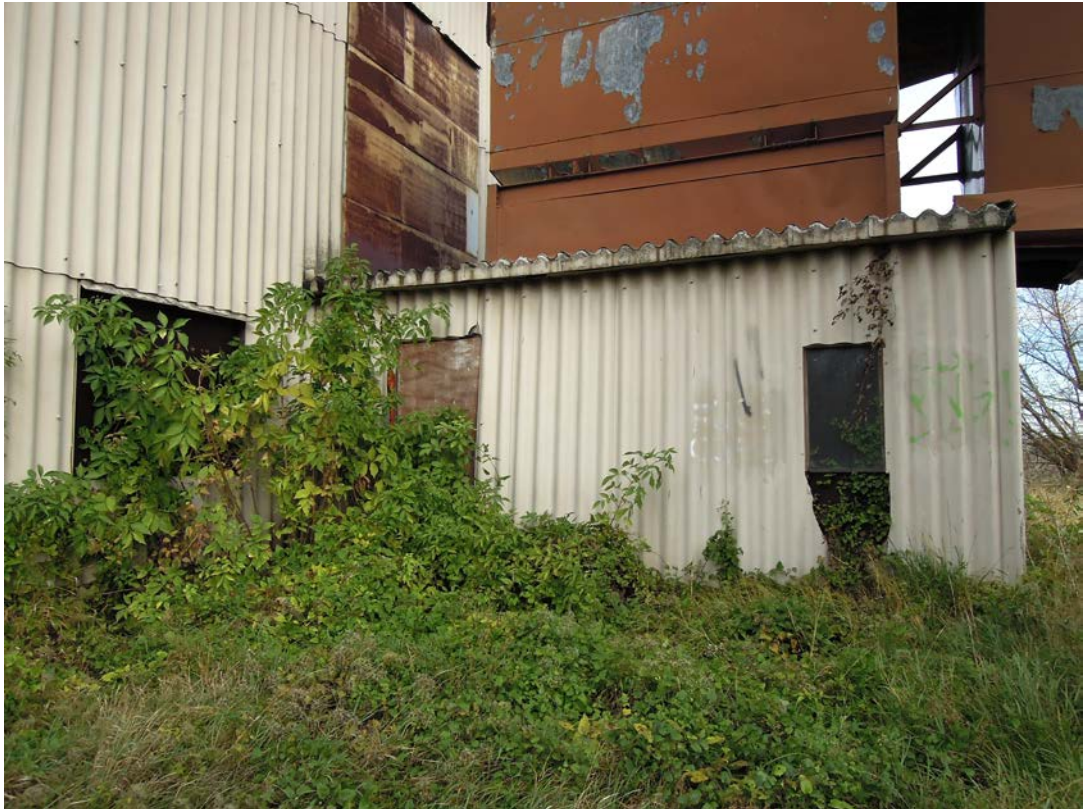
Einhausung des Stahlgerüsts der Entstaubungsanlage. Blick von Süden.
