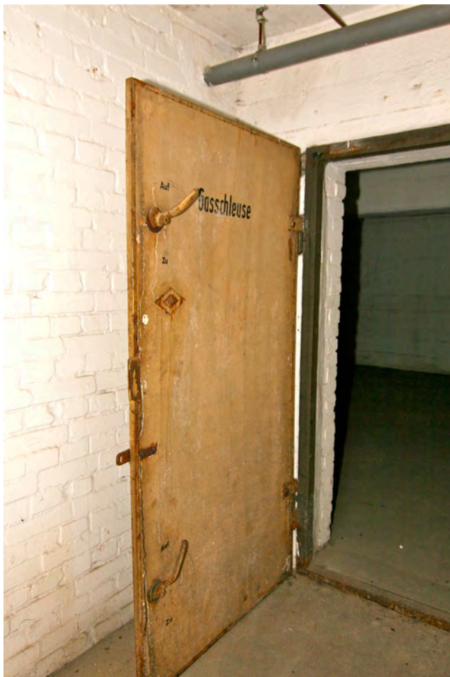
Kellerraum 5, Hazet-Luftschutztür TI 0.1.
