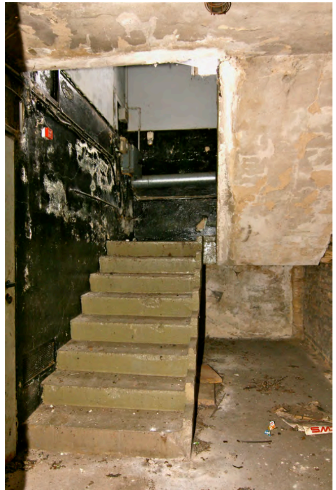
Raum 4, Kellertreppe. Lauf Podest-Kellergeschoss.
