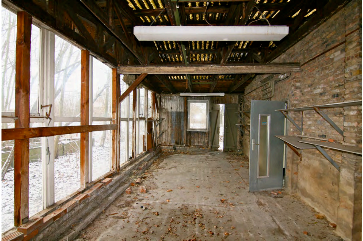
Raum 8, ehemals Raum für Geräte. Blick nach Westen, Eingang TA 3.
