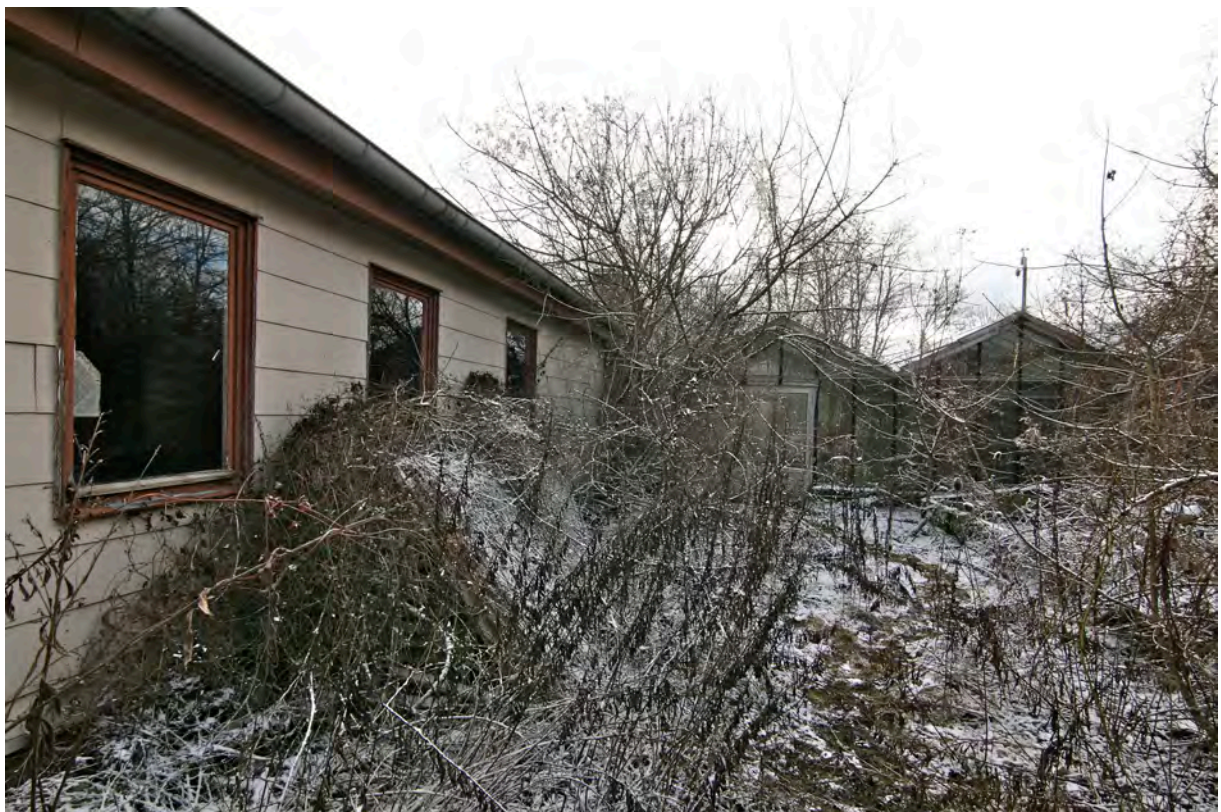
Westseite, rechts Gewächshausanbau Gebäude 107.
