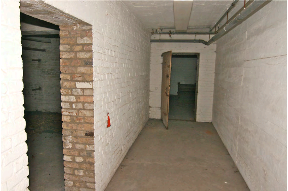
Kellergeschoss, Raum 5, Blick auf Luftschutztür T1 0.1.
