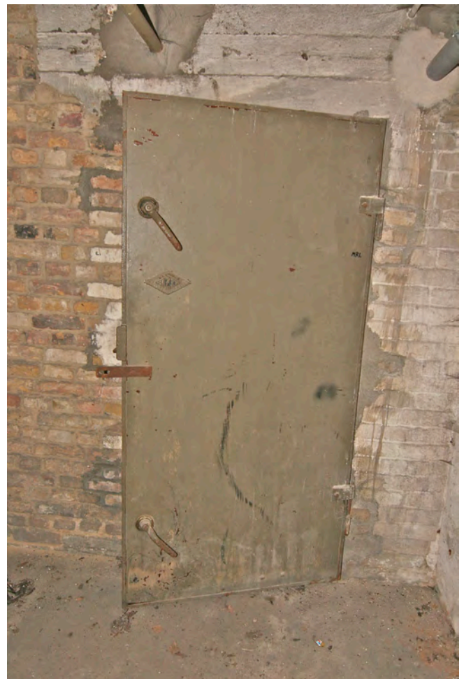
Kellerraum 3, Hazet-Luftschutztür TI 0.2.
