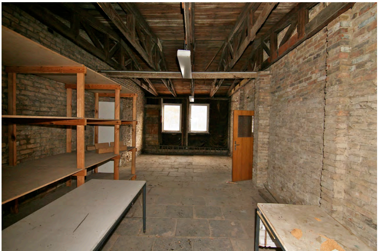
Raum 2, Blick nach Osten. Rechts Tür TI 1.9.
