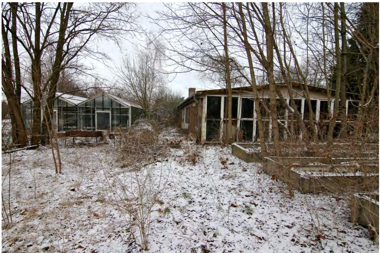
Blick von Süden. Rechts Gärtnerbaracke 108, Giebelseite mit Fensterfront.
