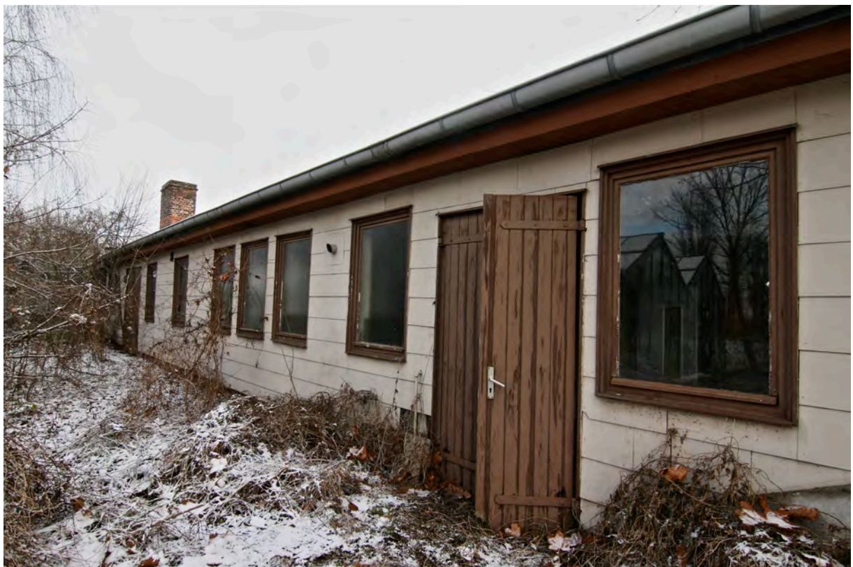
Westseite, Eingang TA 3.
