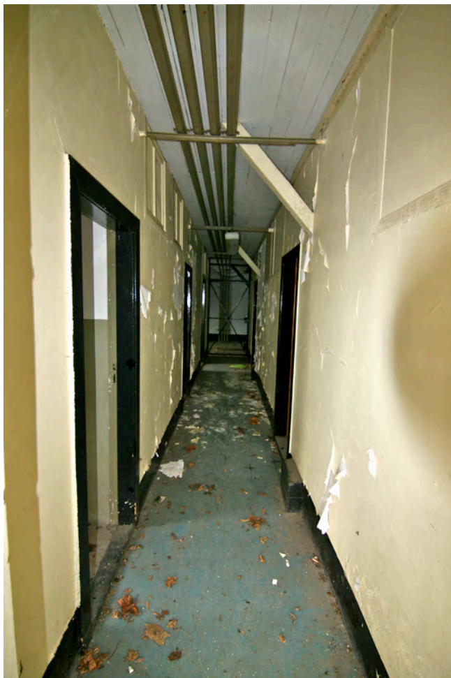
Flur Raum 12, Blick nach Norden auf Gittertür TI 1.7.
