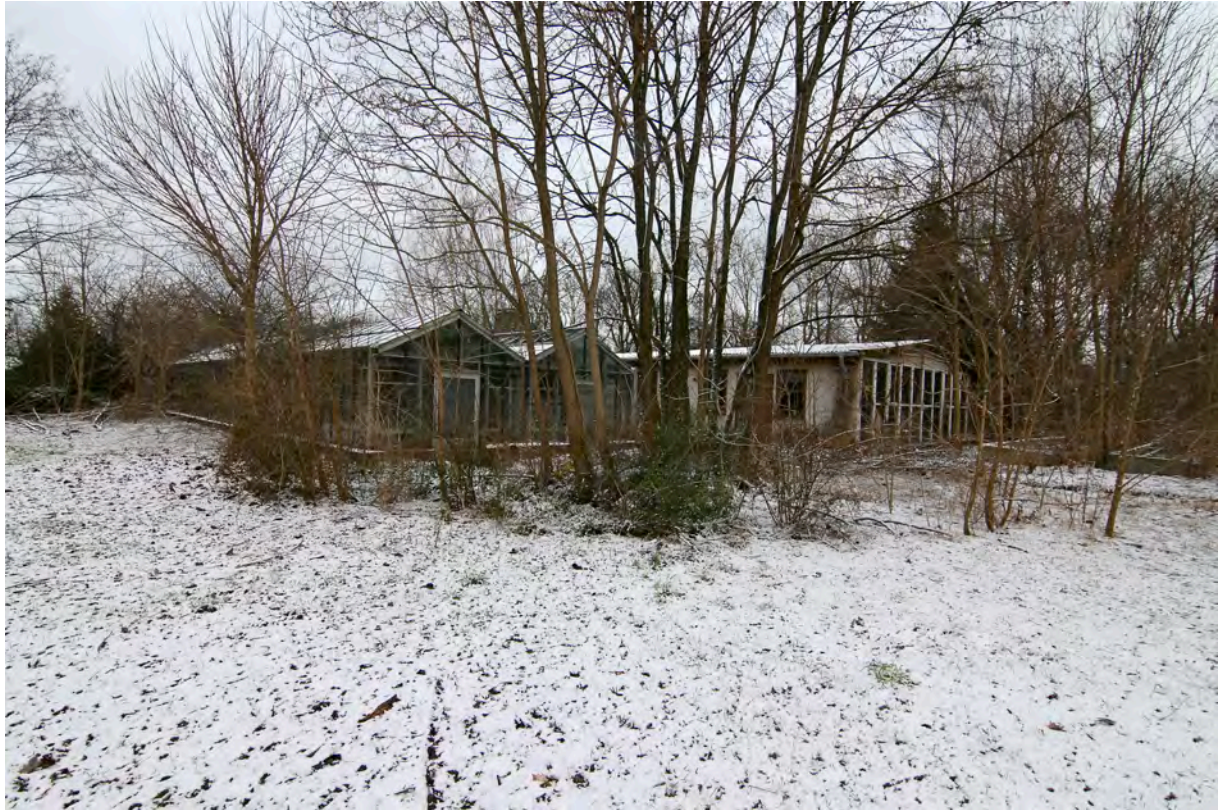
Blick von Süden. Links Gewächshausanbau Gebäude 107.
