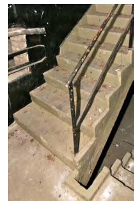
Beton-Kellertreppe, Rohrgeländer.
