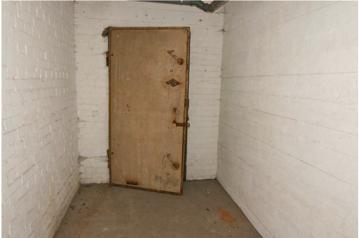
Kellergeschoss Raum 5, Luftschutztür TI 0.1
