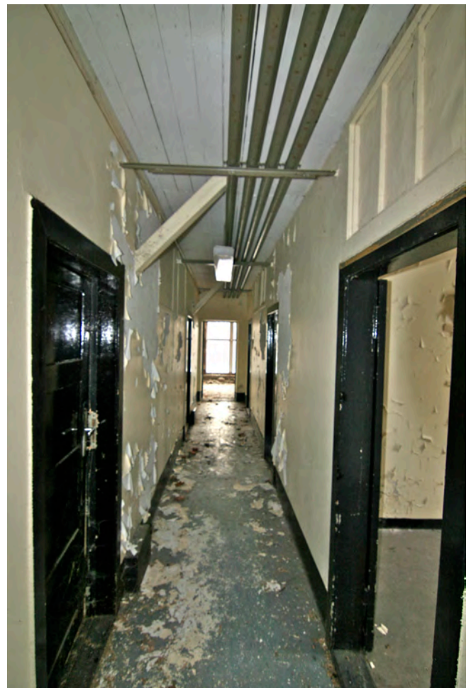
Flur Raum 12, Blick nach Süden nach Raum 8.
