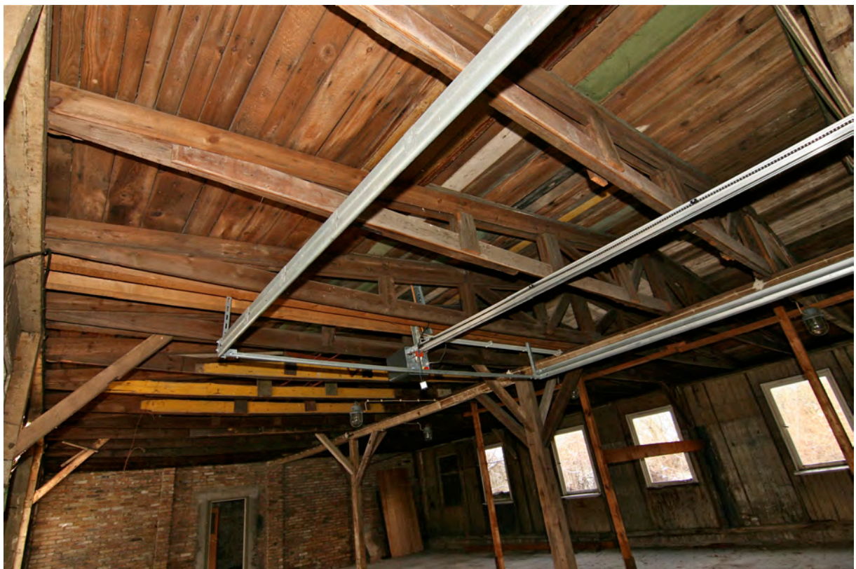
Raum 1, Dachbinder Holzständerkonstruktion.
