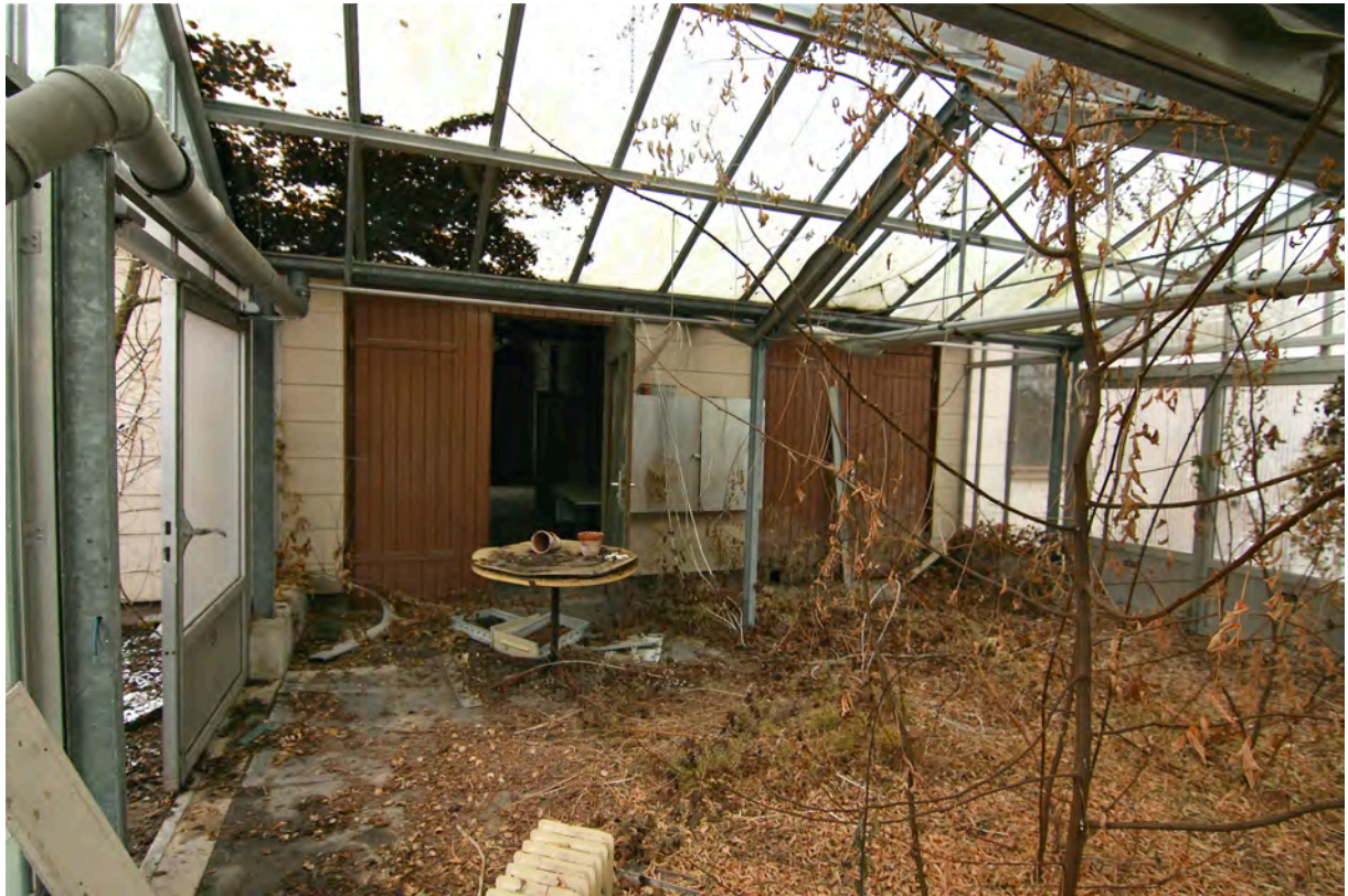
Gewächshausanbau Gebäude 107. Blick auf die Eingänge TA 5 und TA 6 der Gärtnereibaracke 108.
