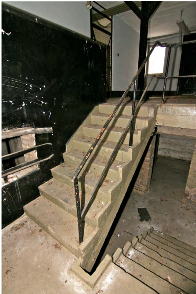
Raum 4, Kellertreppe. Lauf Erdgeschoss-Podest.
