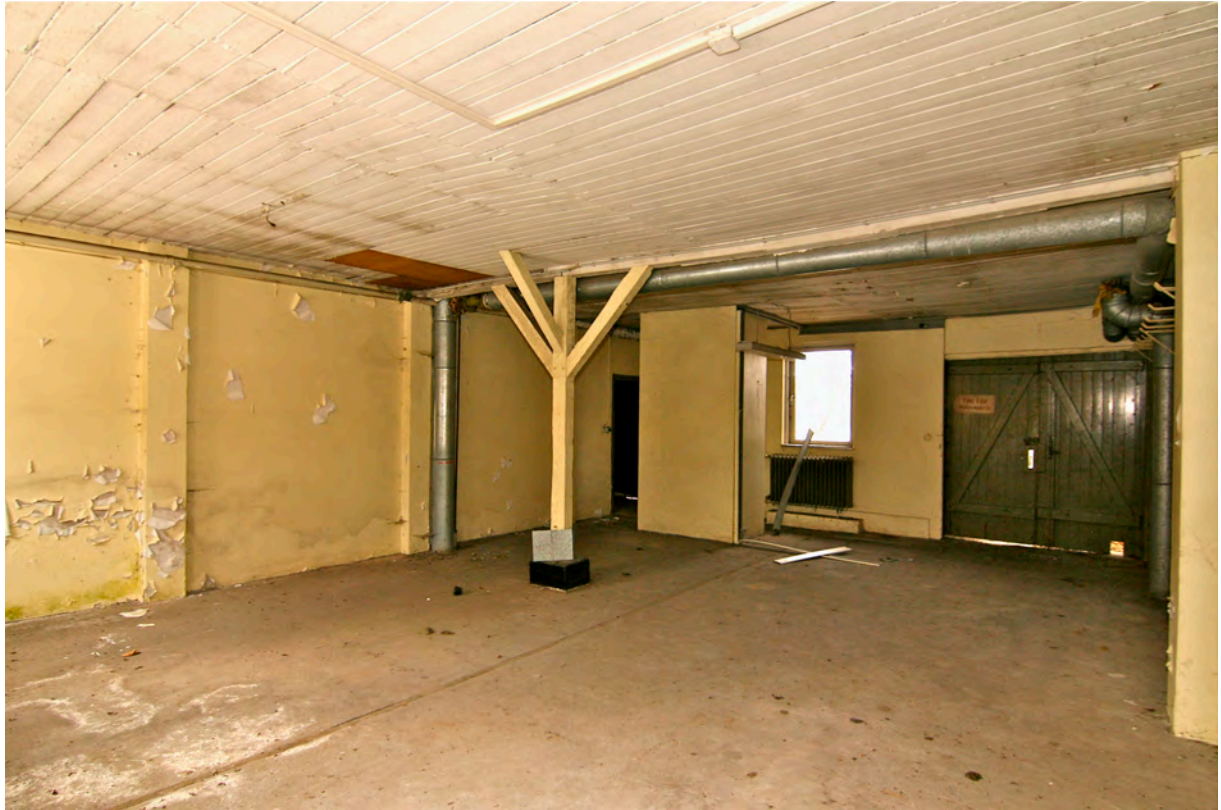
Raum 3, ehemals Arbeitsraum. Rechts Eingangstor TA 5, links davon Schornstein.
