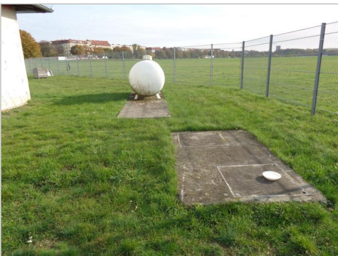
Abbildung 8: Außenbereich Geb. 104 mit baulichen Anlagen Blick nach Südost
